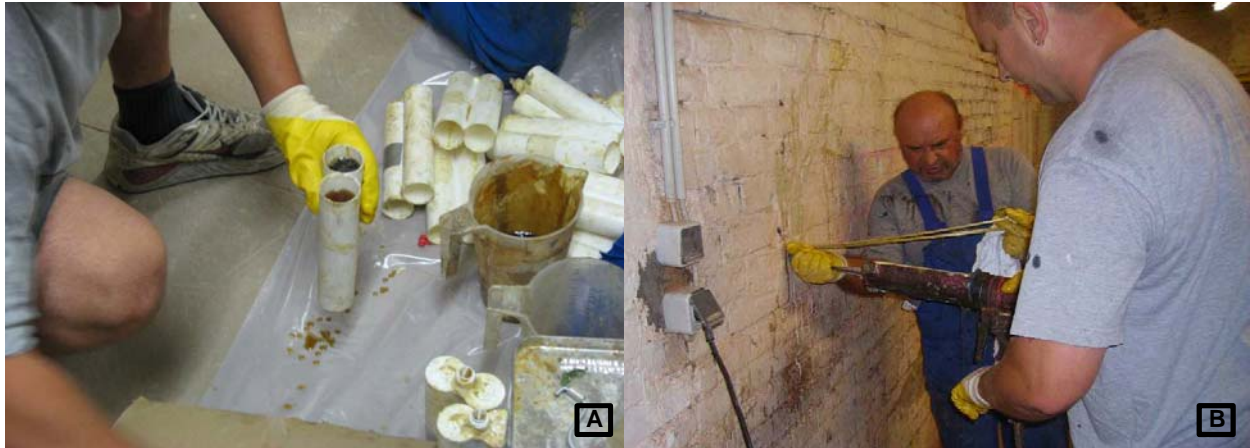
Abb. 5.24: [A] Zwei – Komponenten Injektionsharz; [B] Injizieren der Bohrlöcher
