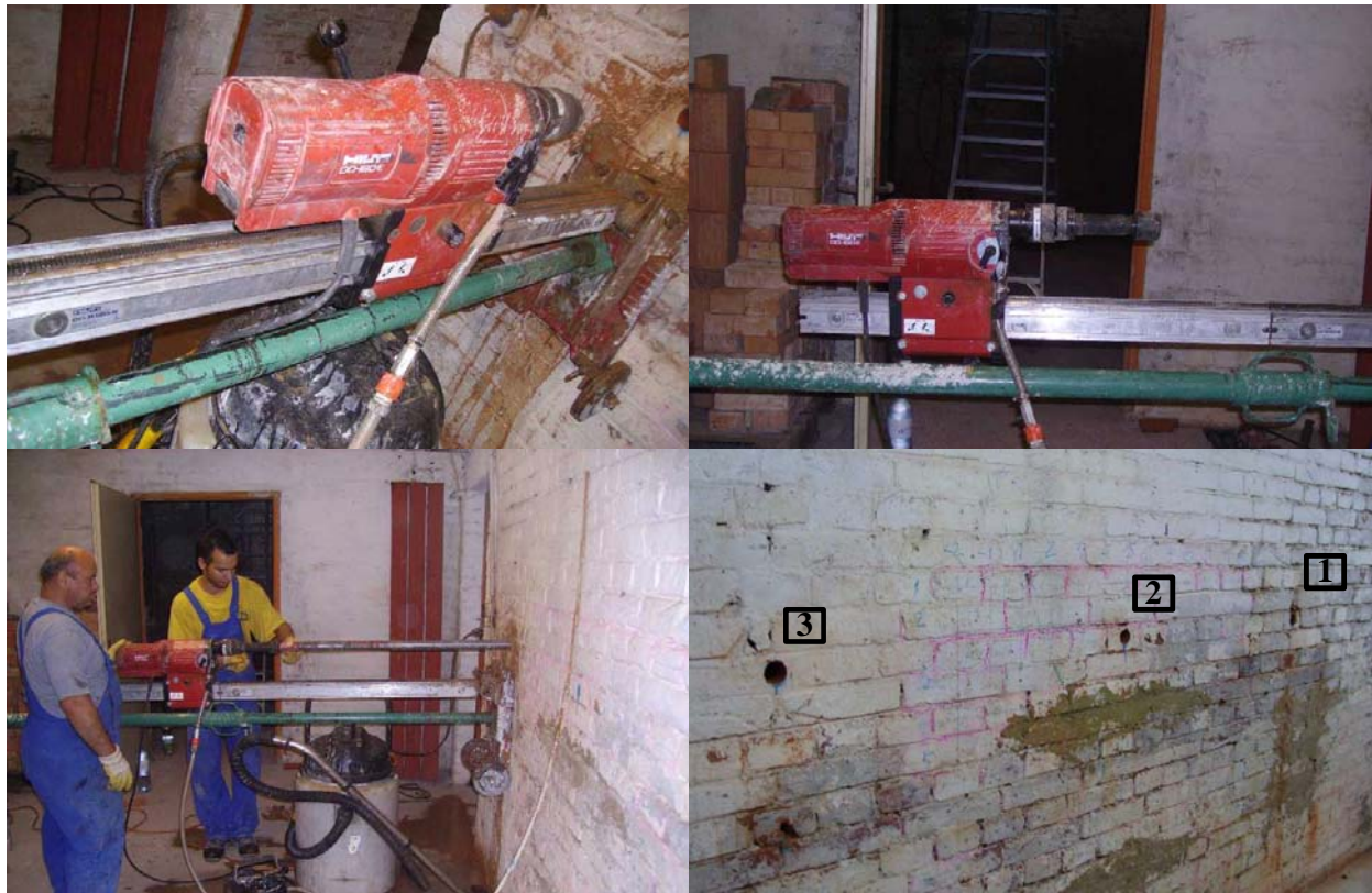
Abb. 5.22: Kernbohrungen; Nummerierung der drei Bohrlöcher
