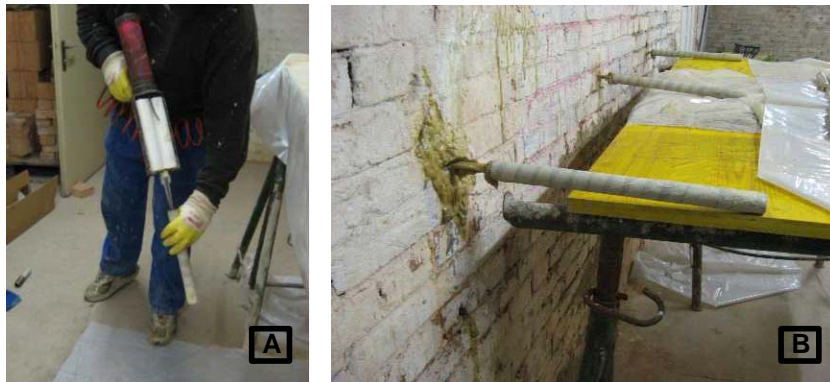
Abb. 5.26: [A] Befüllen der Gewindehülse mit Injektionsmaterial; [B] Darstellung der drei nachträglich angebrachten Gewindehülsen
