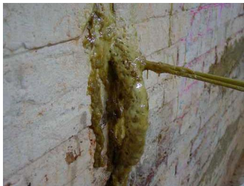
Abb. 5.25: Darstellung des schäumenden Injektionsharzes
