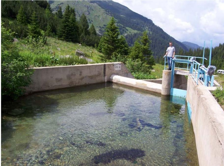
**Abb. 29.1. Seitenentnahme mit festem Wehr und freier Oberfläche (Wasserfassung Nr. 12 des Überleitungskanales (feeding canal) „Maritza 1900“ –  $Q_a = 10,395 \text{ m}^3/\text{s}$ ,  $L = 27,84 \text{ km}$  am Fluß Prava Maritza, Bulgarien)**
