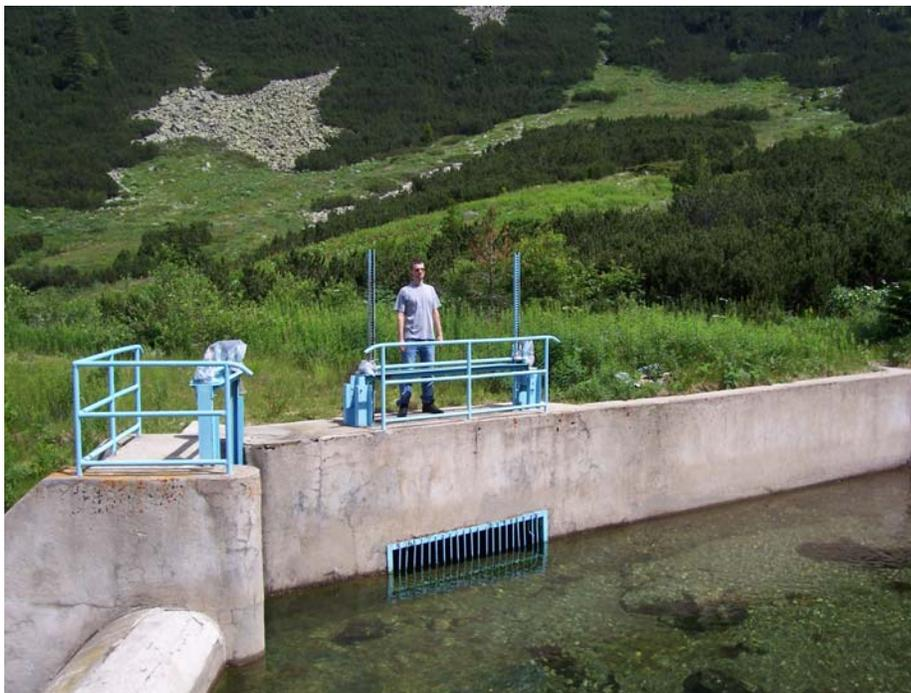
**Abb. 29.2. Seitenentnahme mit festem Wehr und freier Oberfläche (WF Nr. 12 am Fluß Prava Maritza)**
