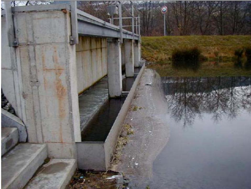
**Abb. 54. Feste Tauchwand [HST Hydro-Systemtechnik GmbH]**
