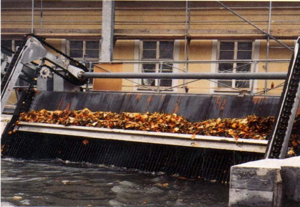
Abb. 57.2. Rechenreinigungsmaschine mit Umlaufkette [55]
