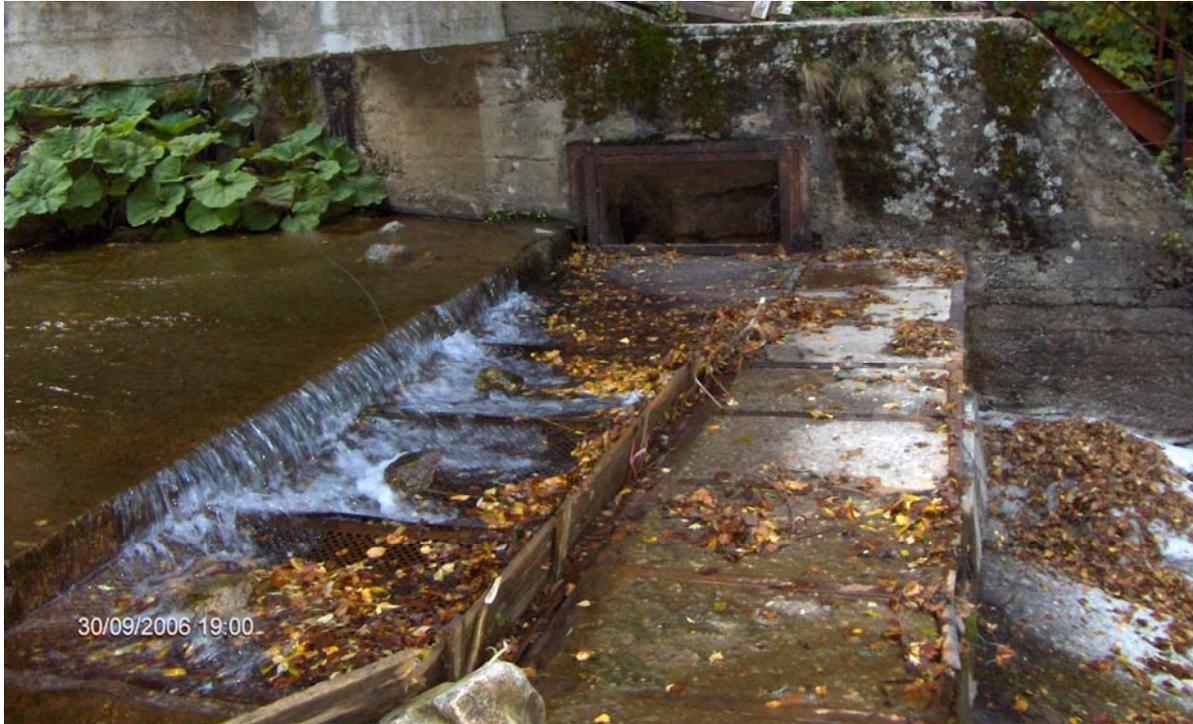
**Abb. 56. 2. Lochblechrechen angeordnet an einer Sohllentnahme am Fluß Sovoljanska Bistrizza am WKW Osogovo, Bulgarien**
