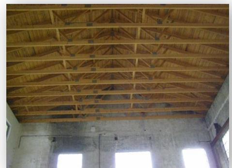
Abb. 136 Kesselhaus Dachstuhl Neu
