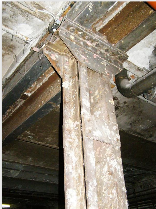
Abb. 120-122 Schmiedeeisenstütze 2011
