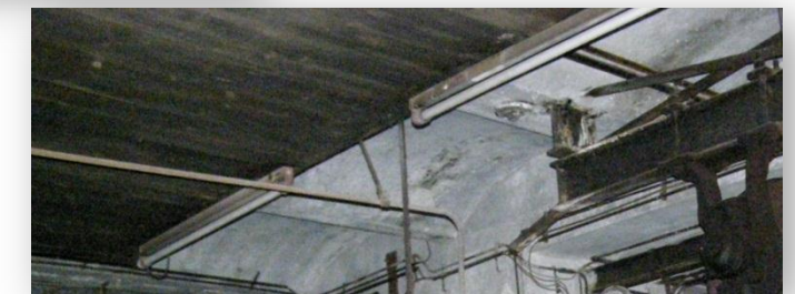
Abb. 109 Tramtraversendecke Untersicht
