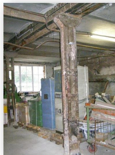
Abb. 140 Genietete Stütze
