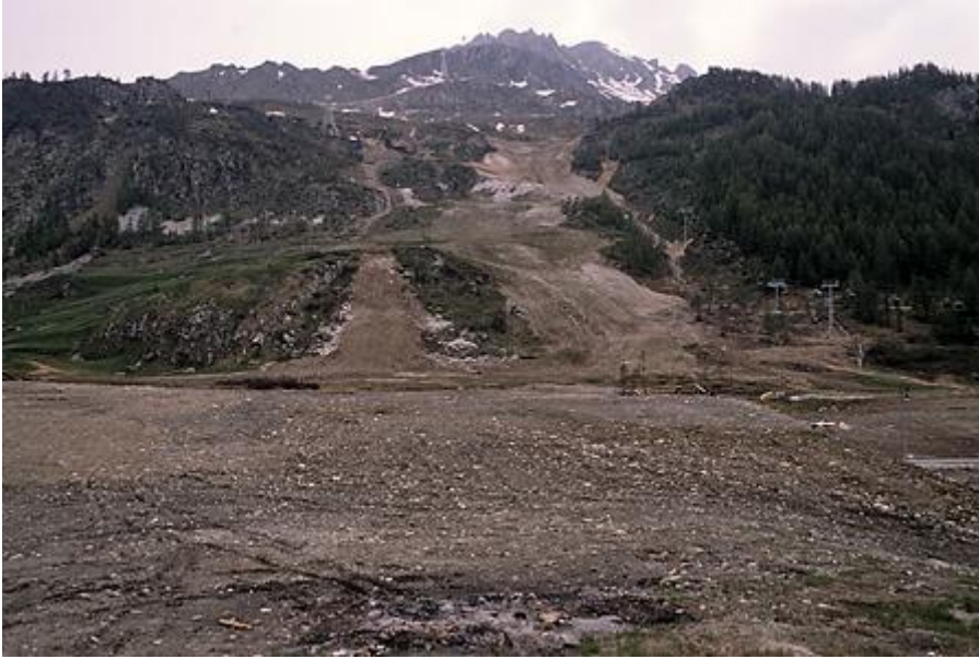
Abbildung 11: Bau der Alpinen Ski-Anlagen in Albertville 1992
