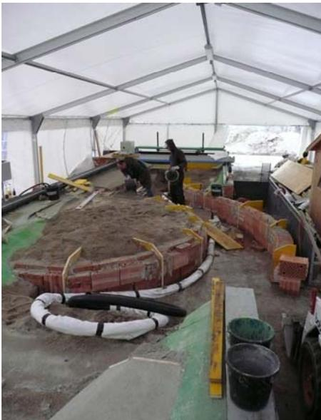
**Foto 6.108: Bau der Mauer für die BU und füllen der Baugrube mit Sand.**
