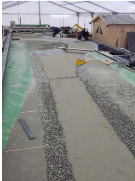
**Foto 6.111: Glattstreichen der Sohle und Aufbringung der Böschungssicherung.**
