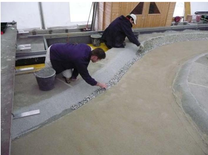
**Foto 6.112: Herstellen des Böschungsfußes und der Böschungssicherung in der Baumleitung.**
