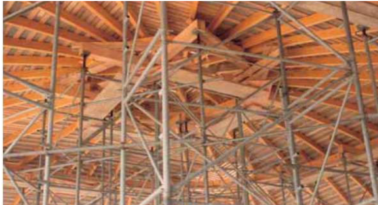
Abbildung 2.7: Schalungsaufwand einer Kuppel [7]
