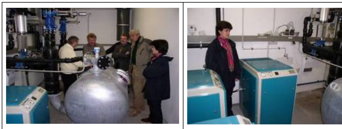
Abbildung 69: Anlage für pneumatischen Abwassertransport
