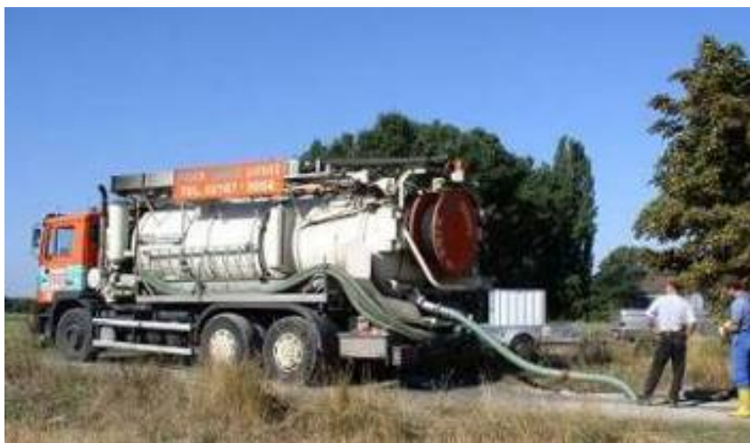
Abbildung 40: Leca Dosierung mit Kanalwagen in Sammler West RHV NSW
