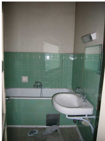
Abb. 10: Badezimmer vor Renovierung
