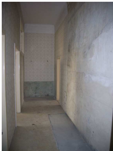
Abb. 12: Vorzimmer vor Renovierung
