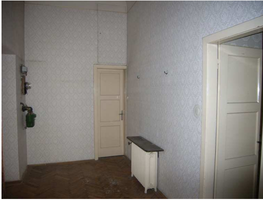
Abb. 8: Vorzimmer vor Renovierung
