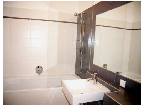
Abb. 11: Badezimmer nach Renovierung
