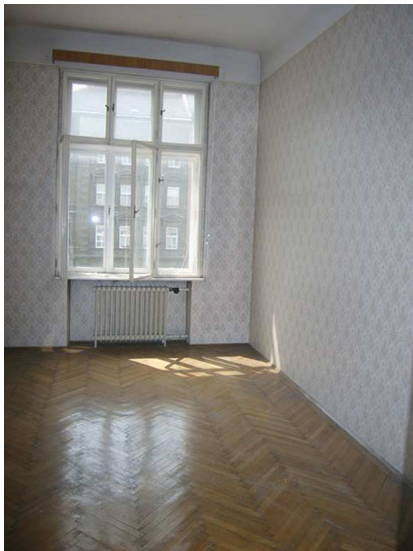
Abb. 16: Kabinett vor Renovierung
