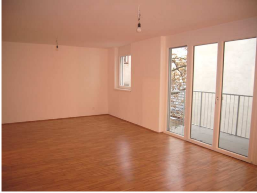
Abb. 1: Blick auf eine Feuermauer
