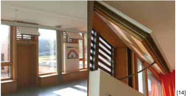
Sommerlüftungsklappen (2 Stück je Klassenraum) im weit geöffneten Zustand
