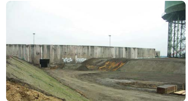
034 Baustelle Rheinpark (Stand: 29.07.2007)
