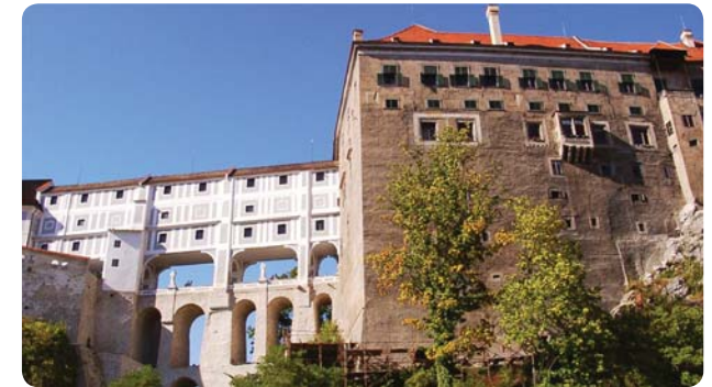
002 Mantelbrücke | Schloss Krumau
