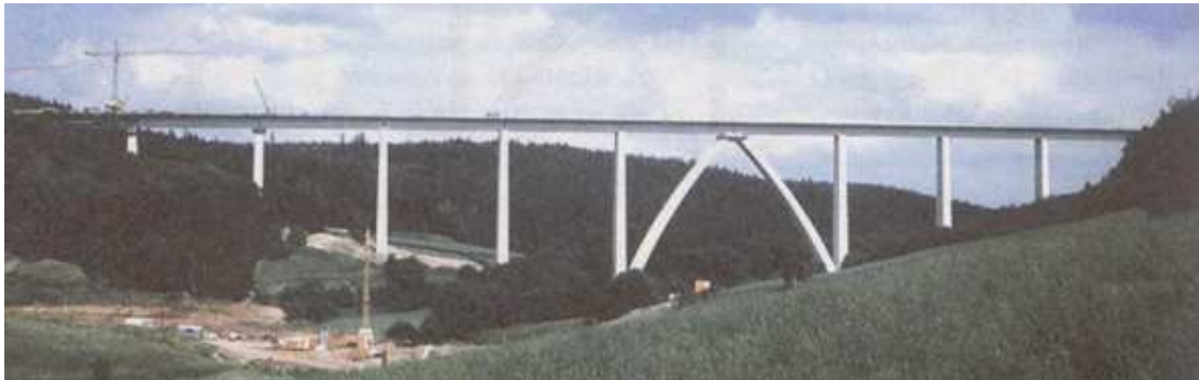
Abb.: 3-18 - Talbrücke mit Festpunkt in Brückenmitte, [20] S.62
