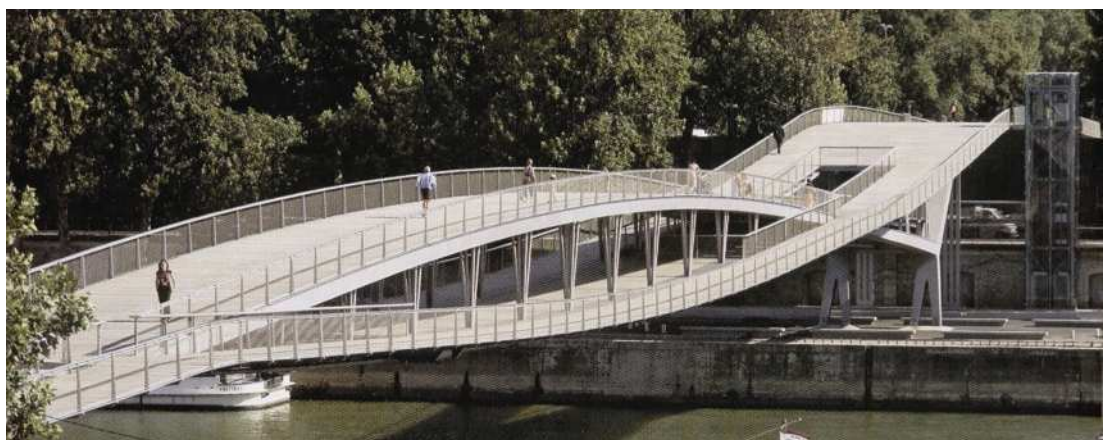
Abb.: 2-9 - Fußgängerbrücke mit Wegeführung auf verschiedenen Ebenen, [13] S.21
