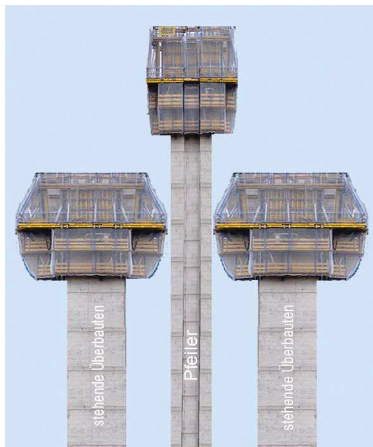
Abb.: 3-7 - Möglicher Bauzustand bei Anwendung der "BLM"
