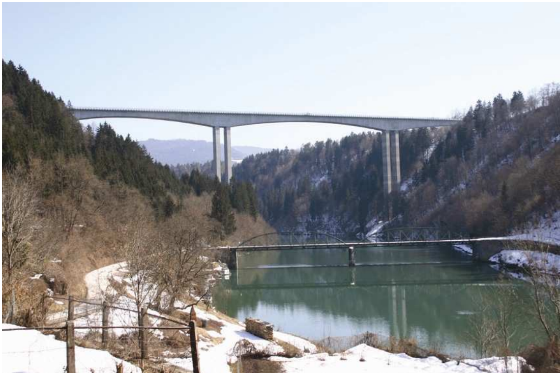
Abb.: 4-4 - Alte und neue Draubrücke von Lippitzbach aus gesehen; Foto: Amt der Kärntner Landesregierung
