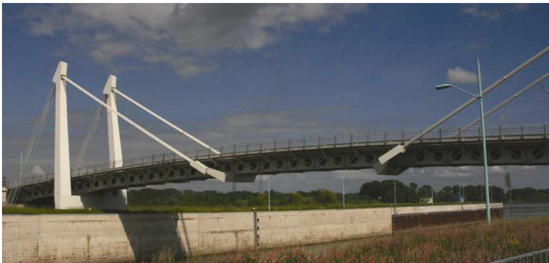
Abb.: 3-15 - Zügelgurtbrücke mit mächtiger Verankerung am Überbau
