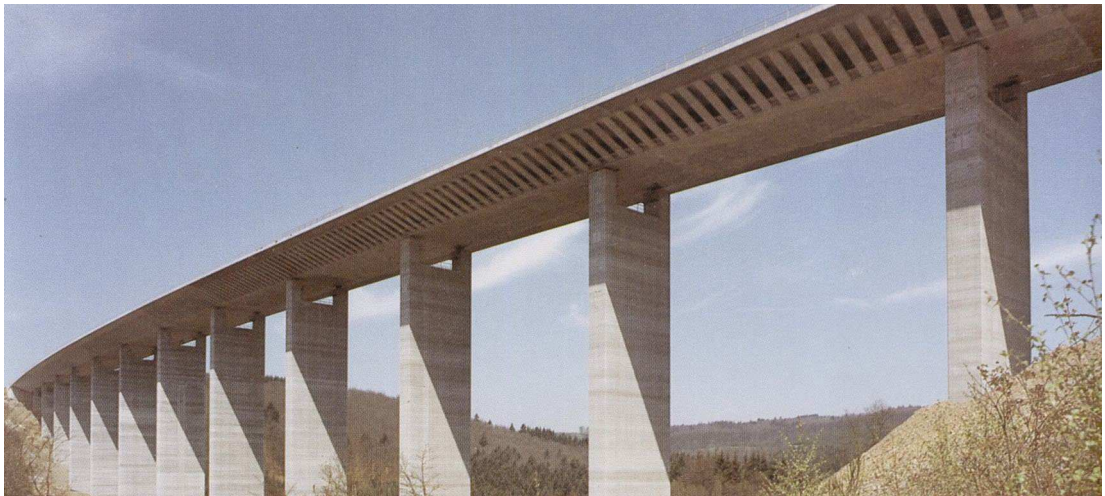
Abb.: 3-9 - Mittels Rippen abgestützte Fahrbahnplatte, [7] S.188
