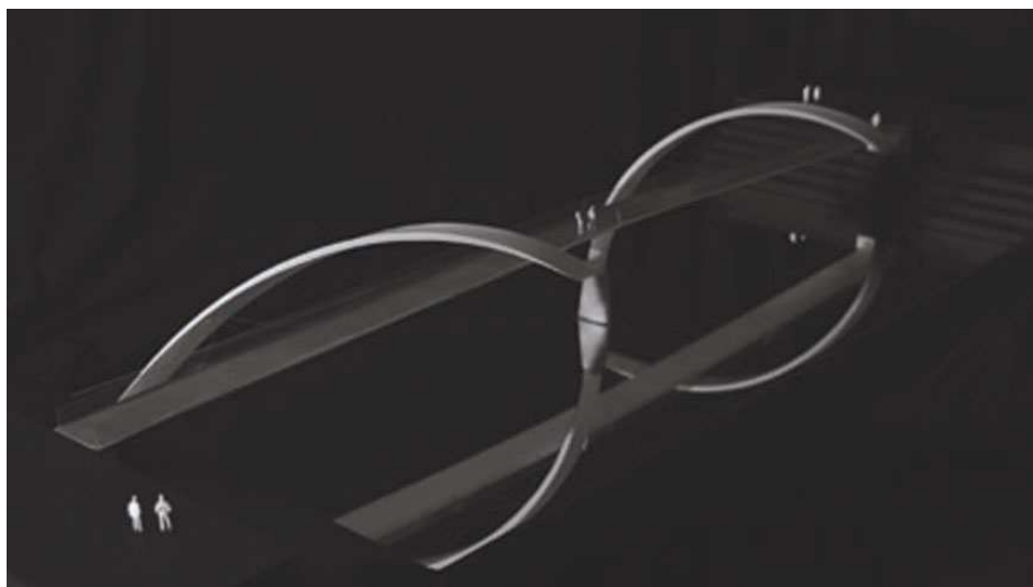
Abb.: 2-28 - The Helix, Fußgängerbrücke mit 2x48 m Spannweite
