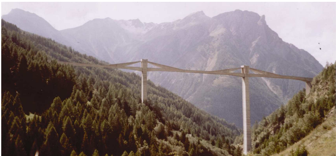
Abb.: 3-16 - Ganterbrücke, Simplonpass CH
