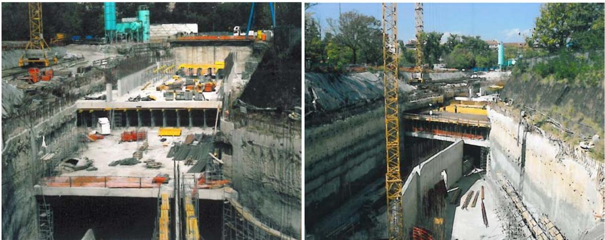
**Abb. 43: Einbau der Zwischendecke mittels Deckenschalung, MS „Vasil Levski Stadion“ [1.38]**
