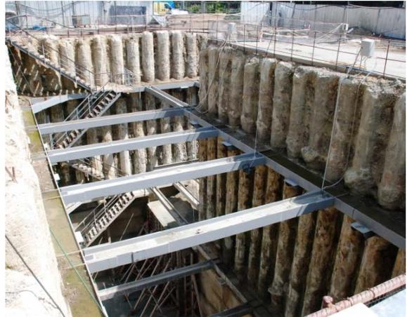
**Abb. 35: Abstützen gegenüberliegender tangierender Bohrpfahlwänden mit Gurte und Steifen aus Stahl, U-Bahn Sofia [2.4]**
