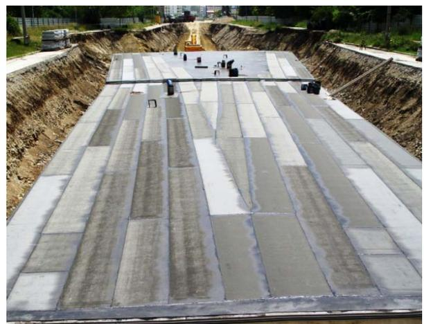
Abb. 27: Verlegte Abdichtungsschicht [2.4]
