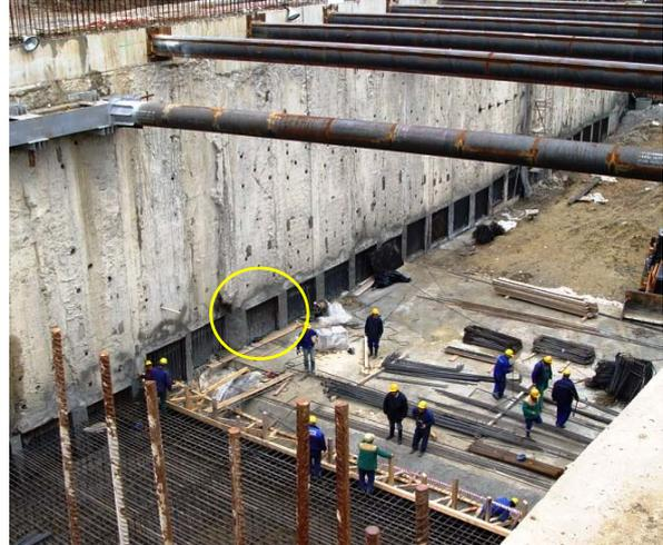
**Abb. 21: Dübelkasten im unteren Bereich einer Schlitzwand, MS "Kl. Ochridski" [1.37]**
