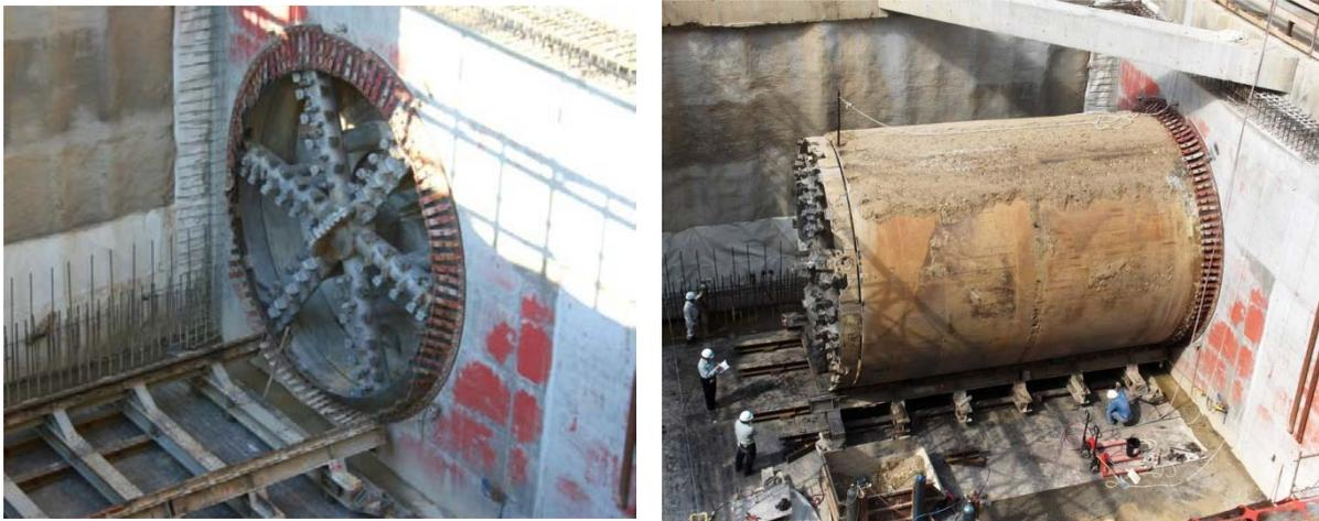
**Abb. 75: Einfahrt des softotischen Erddruckschildes in den Zielschacht [1.37]**
