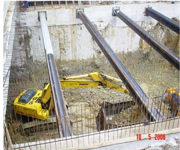
Abb. 24: Aushubarbeiten unter dem Niveau der Abstützung, MS „Kl. Ochridski“ [1.37]
