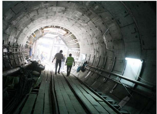
**Abb. 73: Tunnelröhre mit fertiggestellter Tübbingauskleidung, U-Bahn Sofia [2.4]**
