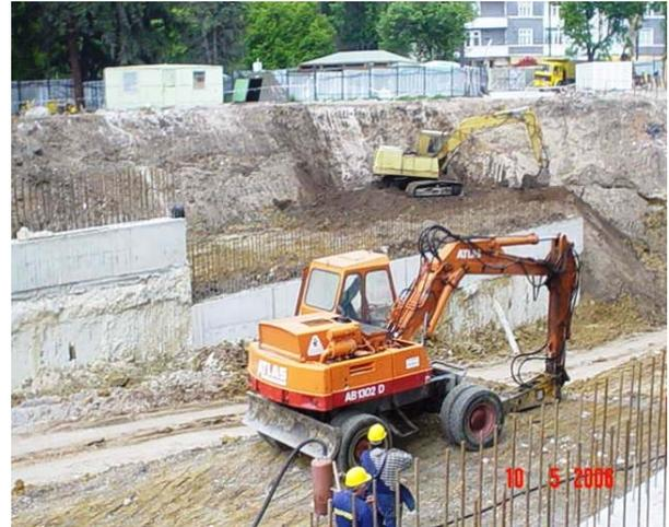
Abb. 23: Aushubarbeiten, MS „Kl. Ochridski“ [1.37]
