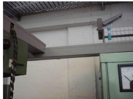
Abbildung 3.14.: Kabelkanal von der Messelektronik zu den Prüfständen
