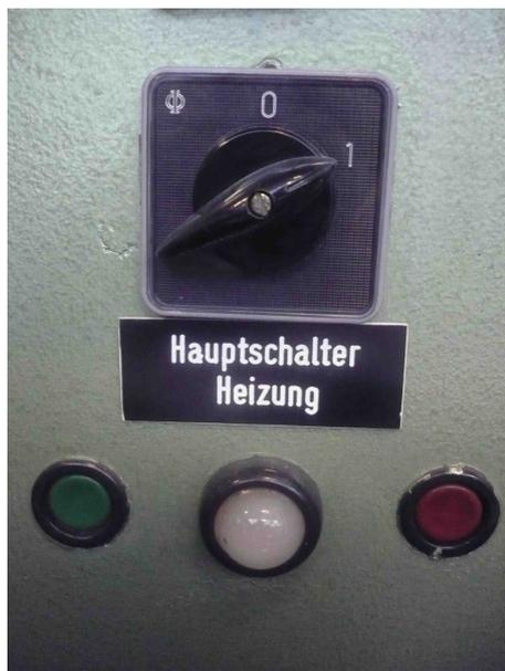
Abbildung 3.41.: Hauptschalter (Eingeschaltet)
