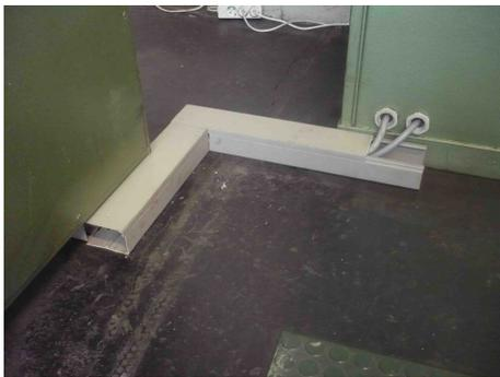
Abbildung 3.13.: Kabelkanal vom Schaltschrank zu den Prüfständen
