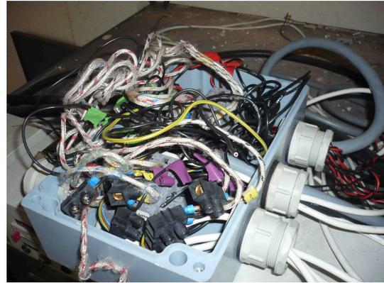
Abbildung 2.5.: Verkabelung auf der Oberseite des Schaltschranks
