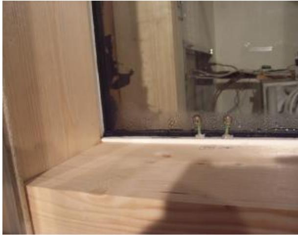
**Abbildung 49: Oberflächenkondensat
