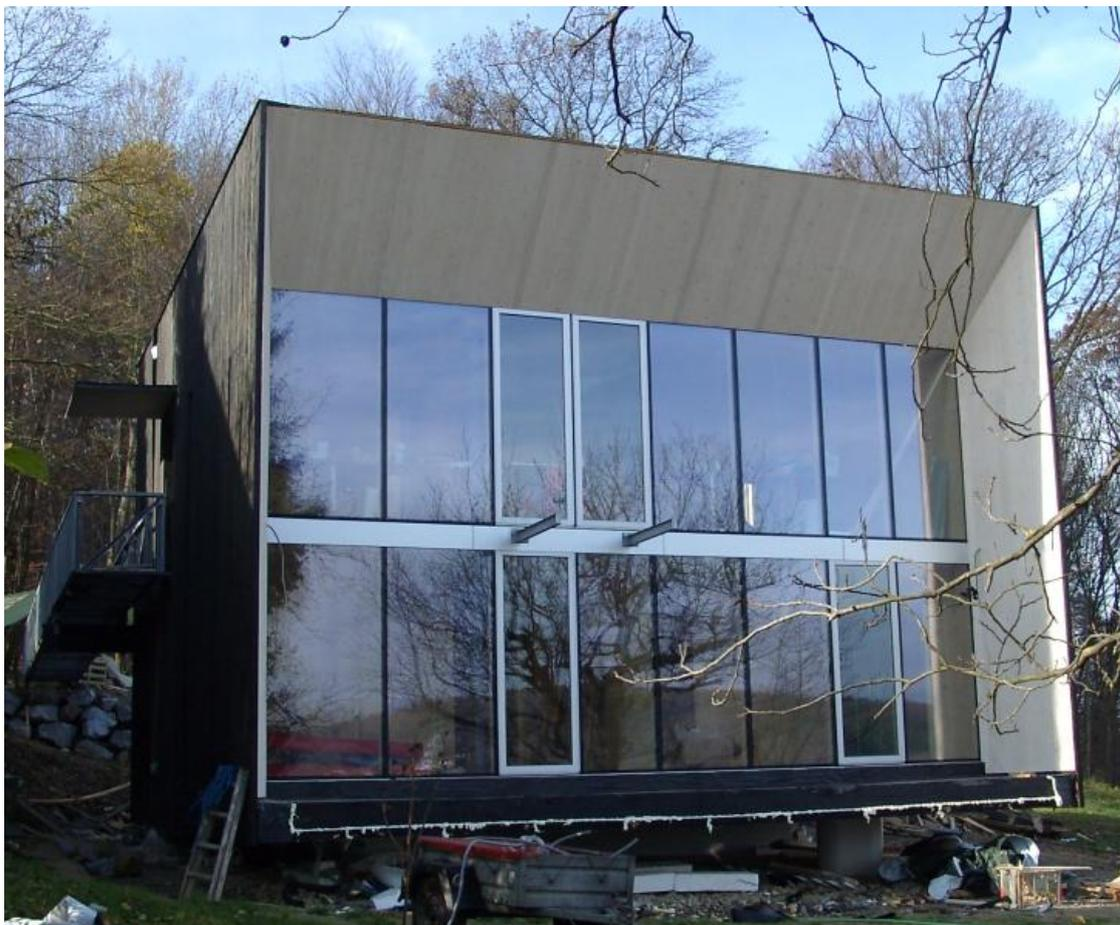
**Abbildung 116: Fertiggestellte Glasfassade Ost**
