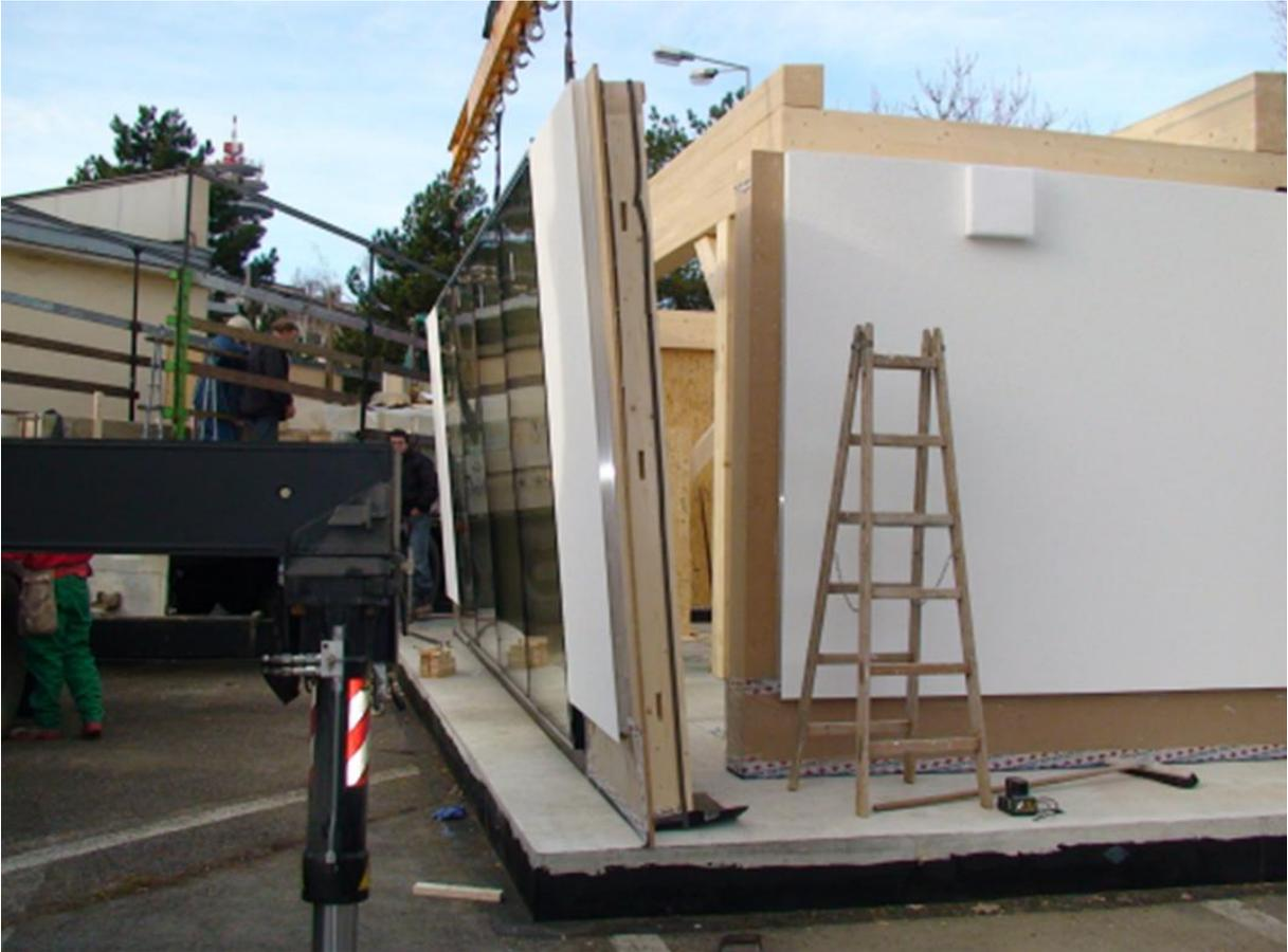
**Abbildung 99: Einheben der Elementfassade**
