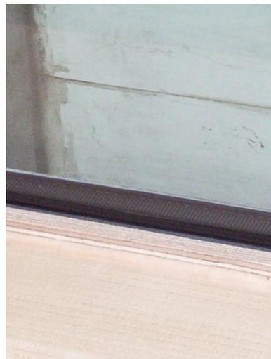
**Abbildung 29 – Oberflächenkondensat durch Einsatz des Heizdrahtes vermieden**
