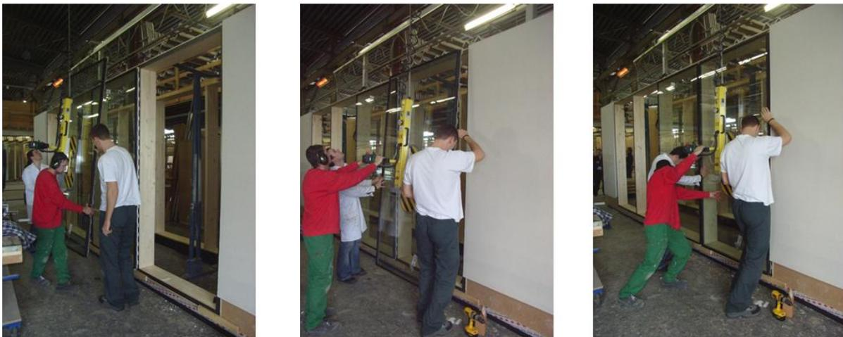
**Abbildung 96: Einsetzen der HGV-Elemente in die Fertigteilwand**
