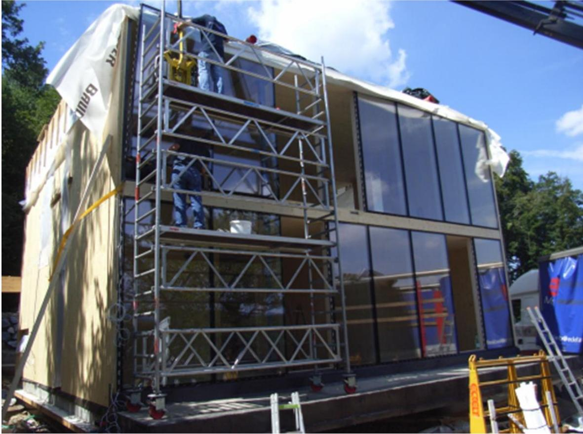
**Abbildung 111: Einsetzen der HGV-Elemente auf der Baustelle**
