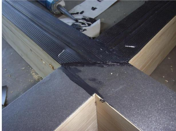
**Abbildung 42: Zwei Dichtungssysteme Tragstruktur / Koppelleiste**
