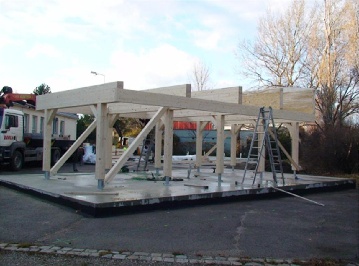
**Abbildung 98: Skelettstruktur des Forschungsgebäudes**
