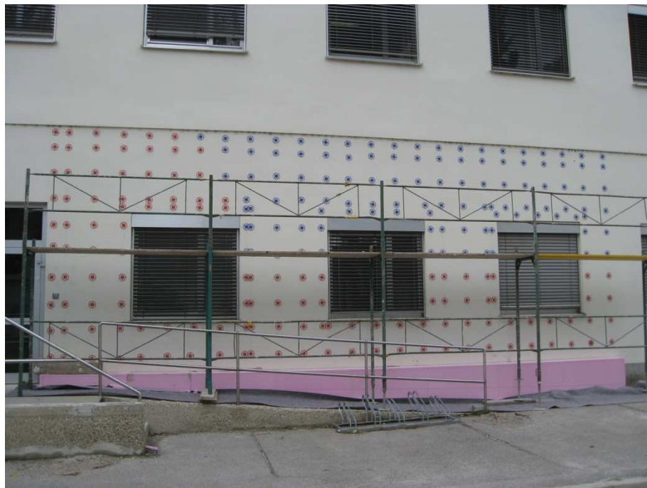
Abbildung 10: Anordnung der gesetzten Anker an der Fassade
