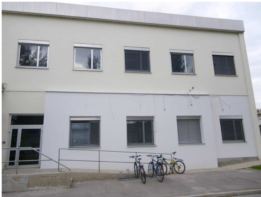
Abbildung 15: Außenansicht des Gebäudes nach der Installation der Messanlage
