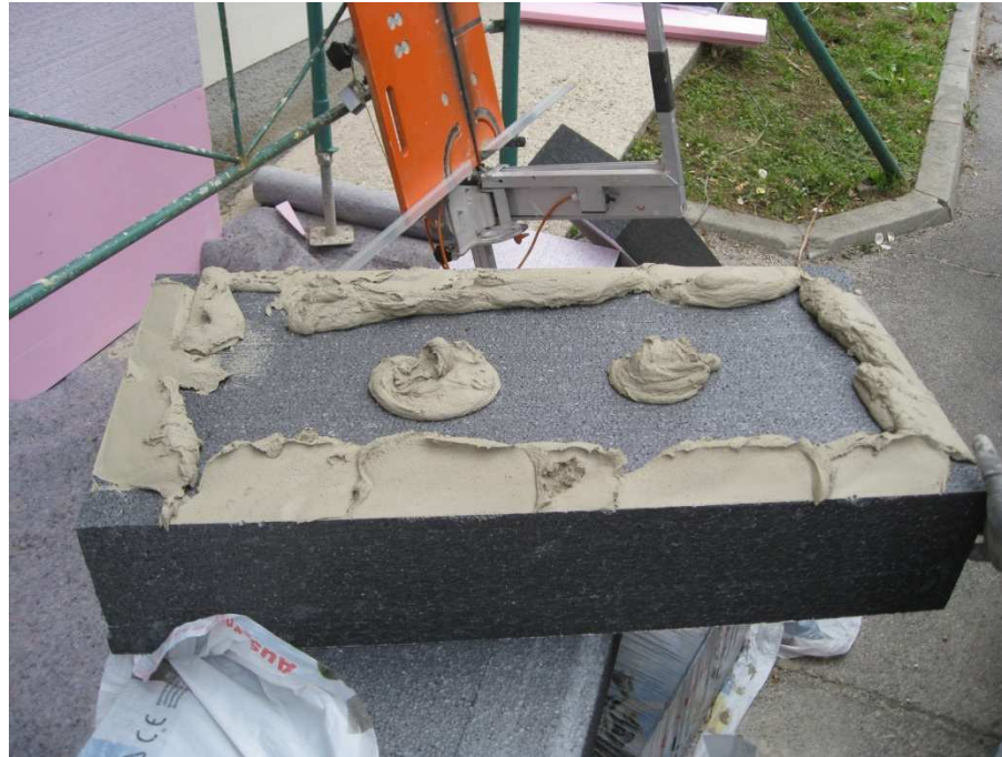
Abbildung 11: „Rand-Wulst-Punkt Methode“ zum Kleben der Dämmung
