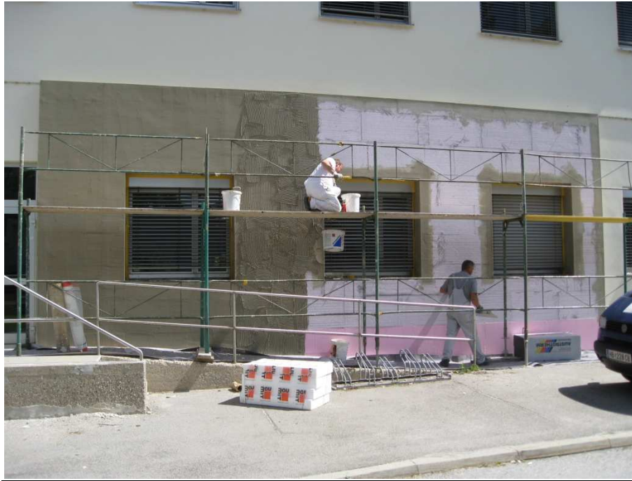
Abbildung 12: Aufbringen des Unterputzmörtels auf das EPS
