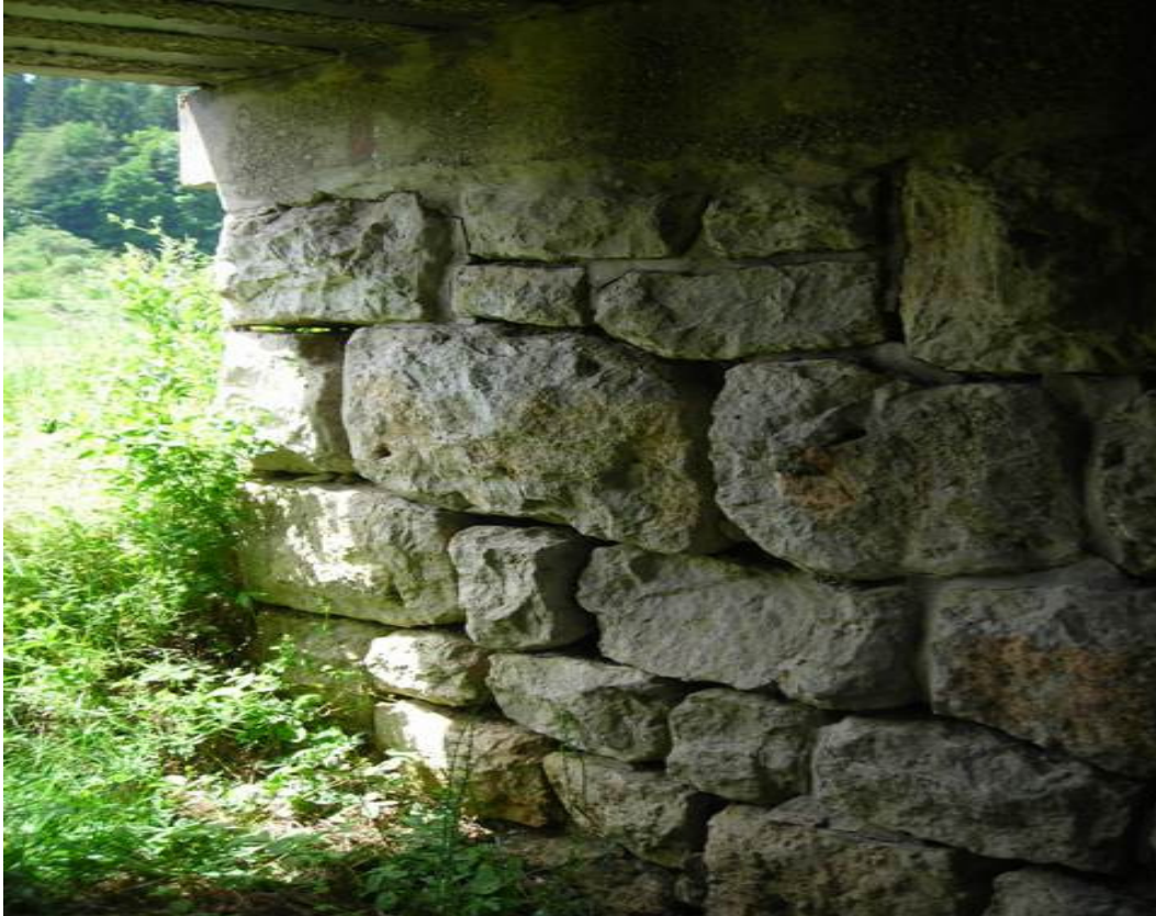
Abbildung 24: Verfugungsschäden [1]
