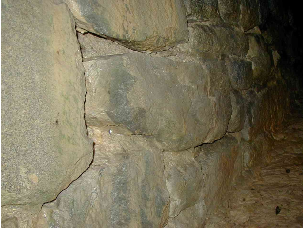
Abbildung 14: Verfungsschäden [1]
