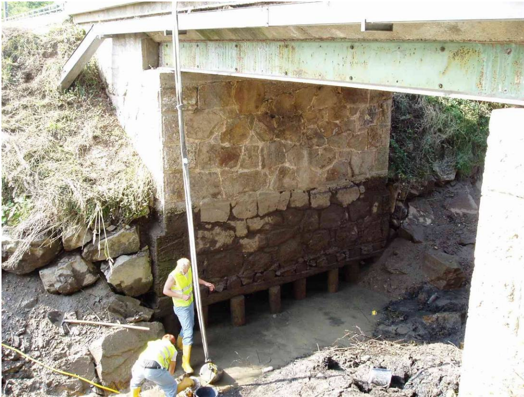
Abbildung 22: Kolkschutz schadhaft [1]
