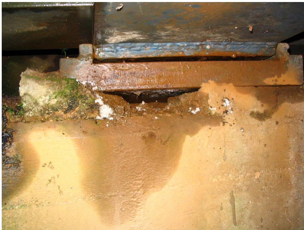
Abbildung 20: Lagerverguss Ausbrüche [2]
