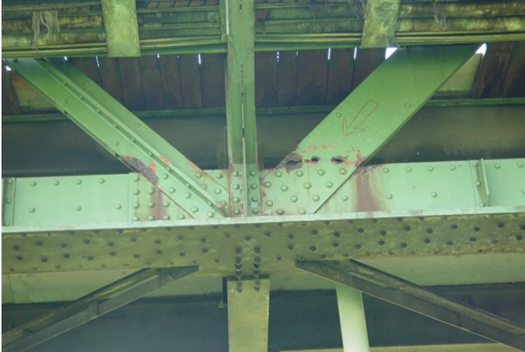
Abbildung 2: Massive Korrosionsschäden [1]
