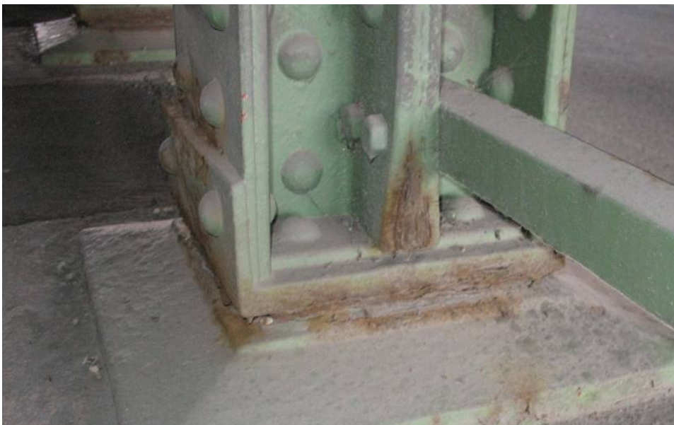
Abbildung 27: Anrostung im Stützenfuß [2]
