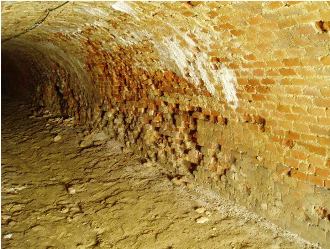
Abbildung 12: Massive Ziegelausbrüche [1]
