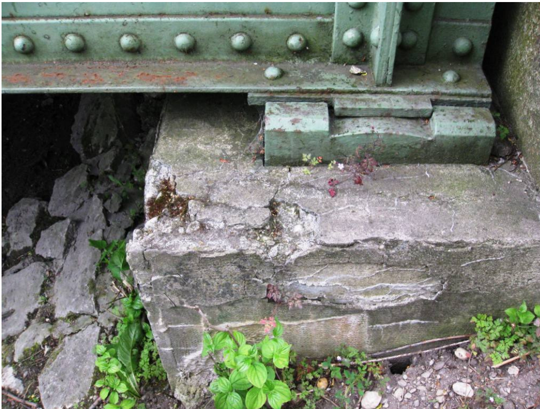
Abbildung 23: Betonausbrüche [2]
