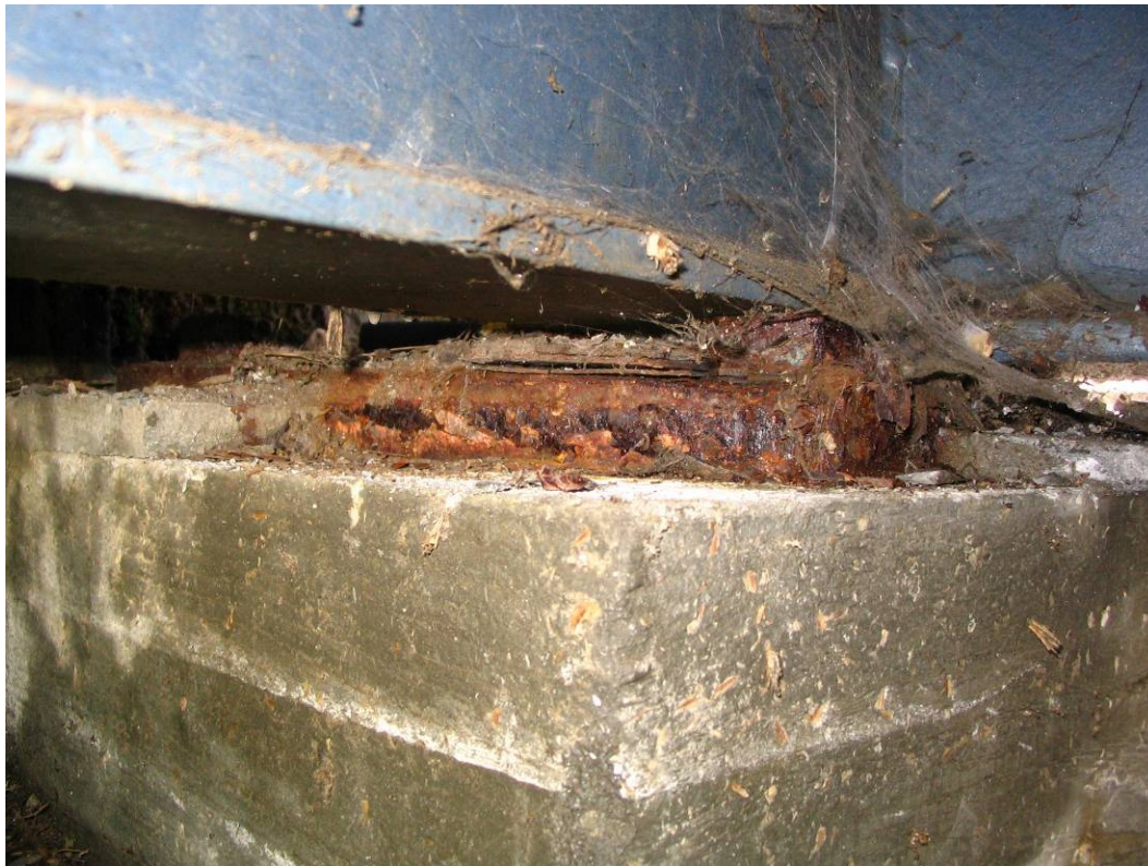
Abbildung 18: Korrosionsschaden [2]
