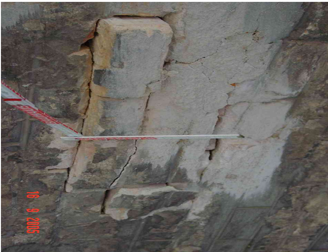
Abbildung 13: Beginnende Auflösung des Gefügeverbandes [1]
