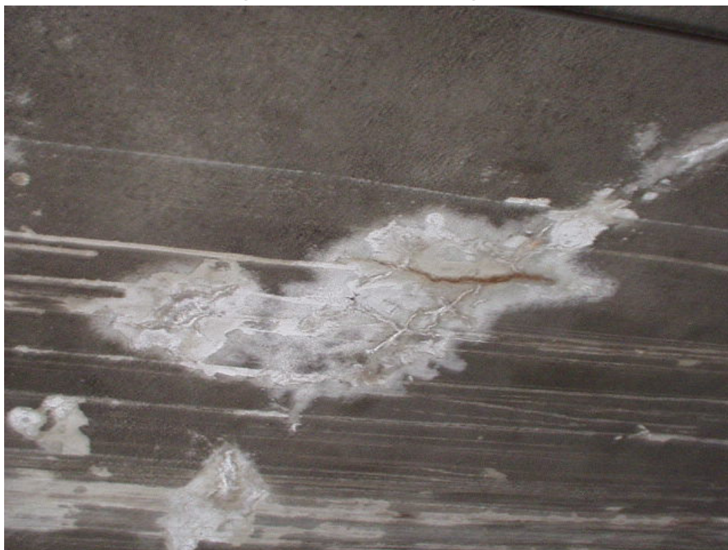
Abbildung 7: Aussinterungen [1]
