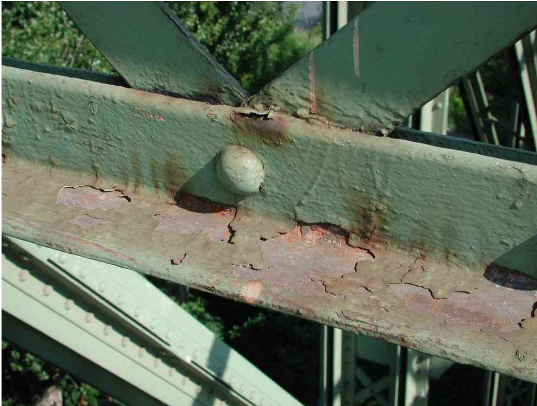
Abbildung 1: Korrosionsschäden [1]
