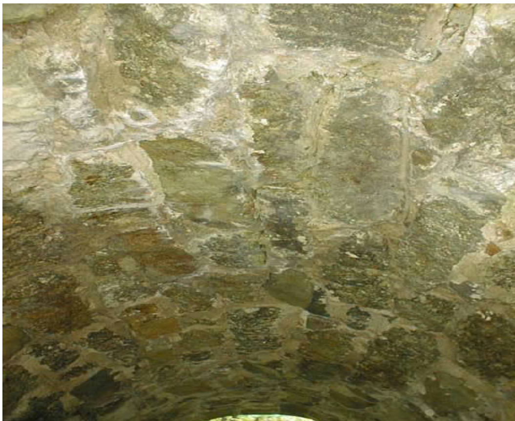
Abbildung 17: Durchfeuchtung [1]
