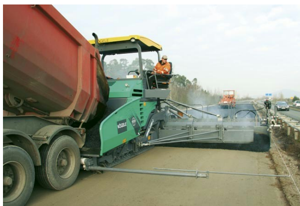
Abb. 1.1: Straßenfertiger Voegelé S2001-2 mit mechanischer Abtastung eines Führungsleitdrahtes ( www.voegele.info )
