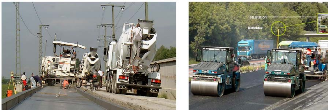
Abb. 1.2: Pilotprojekte zur 3D-Steuerung von Baumaschinen: Gleitschalungsfertiger der ICE-Neubaustrecke zwischen Frankfurt und Köln, 1999 (links, Stempfhuber und Ingensand, 2008). Asphaltfertiger beim Autobahnabschnitt zwischen Wil und St. Gallen, 2000 (rechts, Zimmermann und Konrad, 2003)
