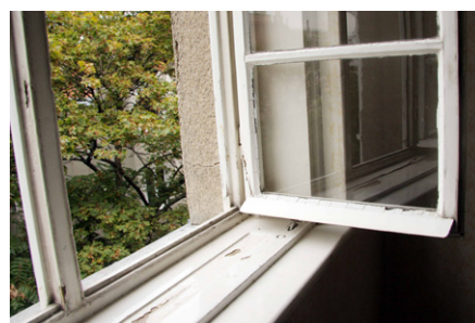
Fig. 33: Kastenfenster im Bestand
