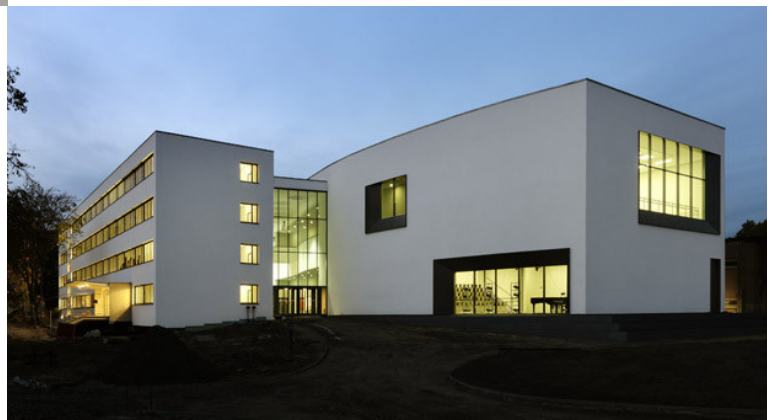
Abb. 40+41: Staatliche Ballettschule Berlin und Schule für Artistik, Berlin, Gerkan Marg und Partner Architekten
