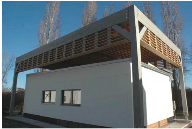
Bild 1. Südwestansicht des Forschungshauses B mit überstreichendem Beschattungselement zur Simulation einer dauerhaften Beschattung
