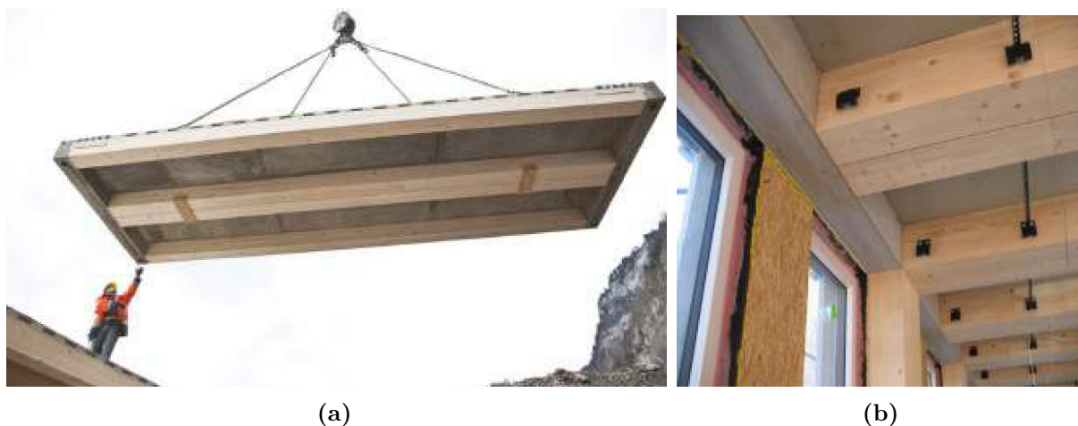
Abb. 2.2: (a) HBV-Decke als Fertigteile wird im LCT ONE angebracht [5], (b) Eingebaute HBV-Decke mit Stahlbetonrandträger aus Brandschutzgründen [5]
