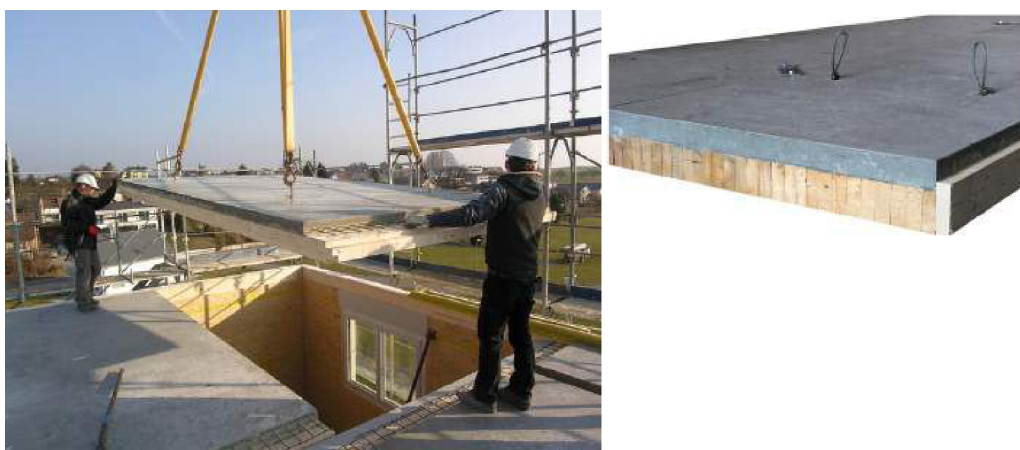
Abb. 2.3: HBV-Decke mit Holzteilquerschnitt aus Brettstapelelementen in Zürich [5]
