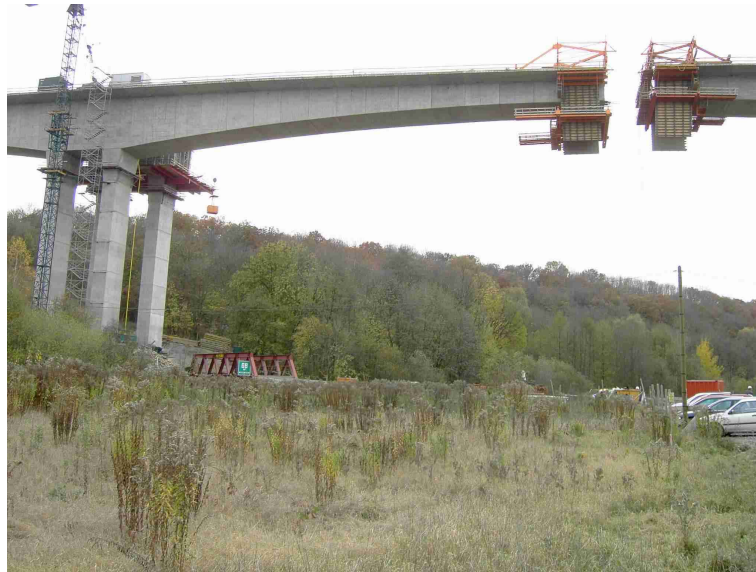
Abb. 1.4: Weidatalbrücke im Bauzustand (im Freivorbau errichtet) [35]
