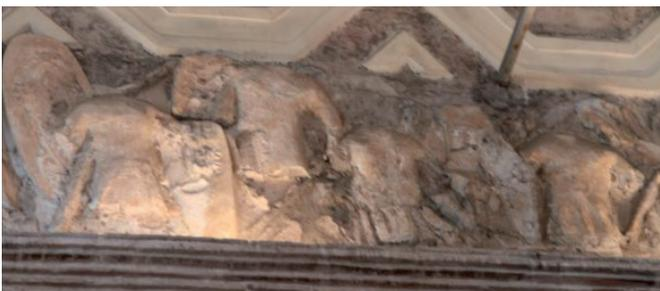
zwischen den Wänden und der Decke ist als horizontale Gliederung mit Stuckfries ausgebildet, der jedoch schwer beschädigt ist (Abb.12).
