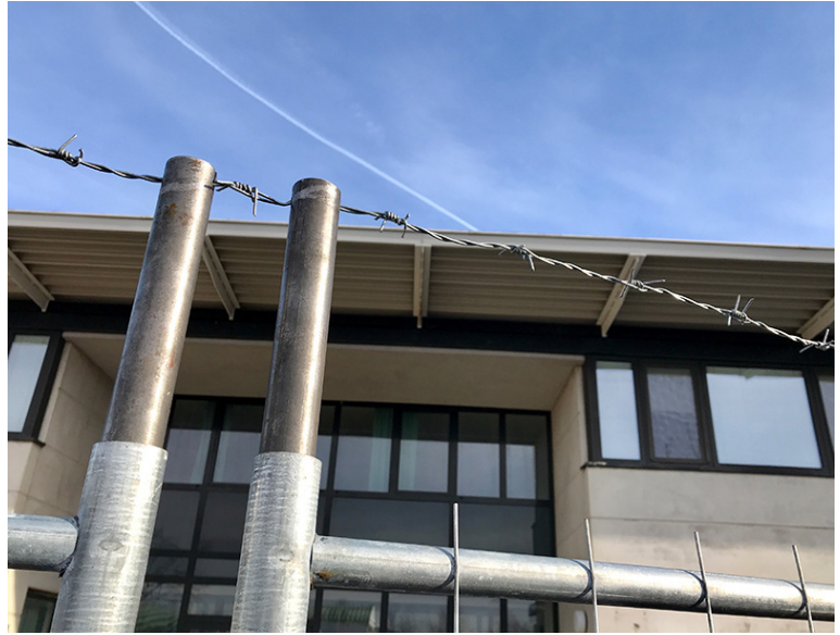
Abbildungen: 101: Das Asylquartier ist mit einem Bauzaun und Stacheldraht gesichert 102: Asyl-Quartier, Drasenhofen
