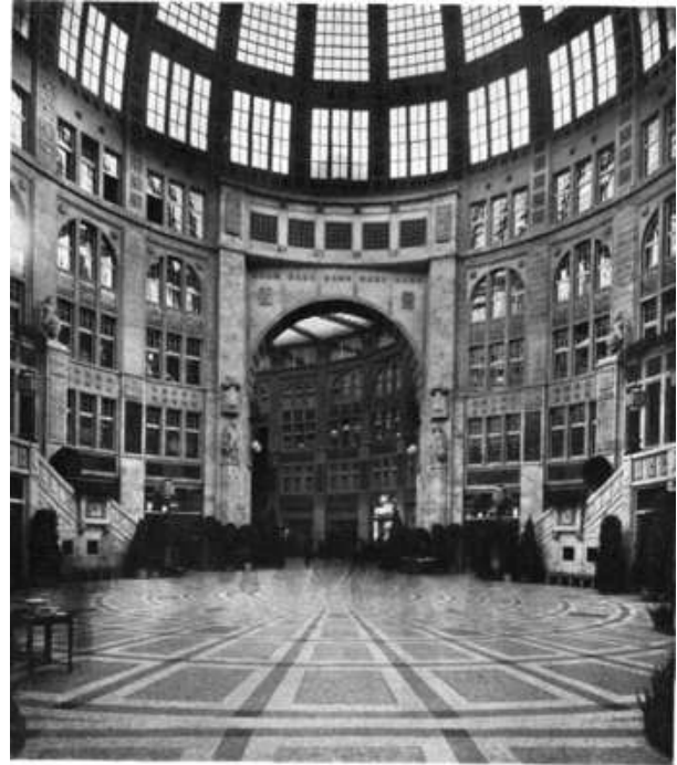
Abbildung 66: Friedrichstraßen-Passage; Kuppelraum mit identischen Freitreppen, 1909
