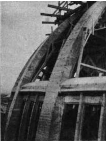
Abbildung 18: Rüstung mit Schalung für die Eisenbetonrippen der Kuppel, 1908
