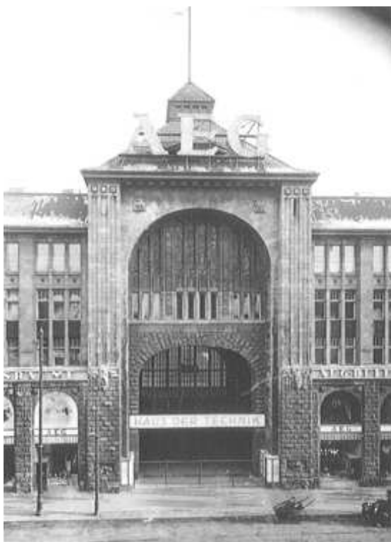
Abbildung 81: „Haus der Technik“; Torbau an der Friedrichstraße mit „Haus der Technik“-Schriftzug, 1928
