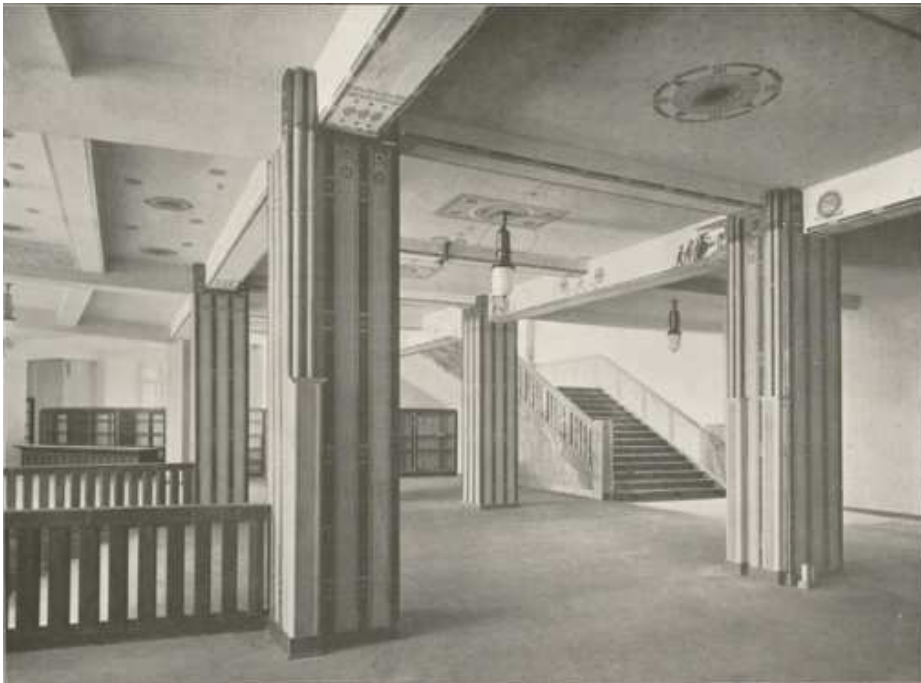
Abbildung 17: Verkaufsraum mit Stützen, 1909
