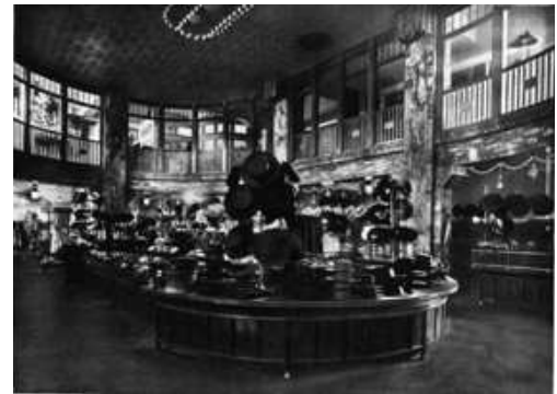
Abbildung 72: Friedrichstraßen-Passage; Zwischengeschoss „Gelber Saal“ mit temporärer Hutabteilung, 1908
