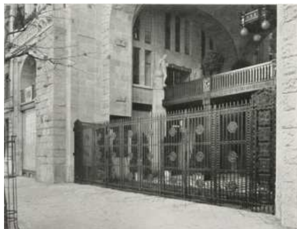
Abbildung 76: Friedrichstraßen-Passage; schmiedeeisernes Tor am Torbau a. d. Oranienburger Straße (v. Golde und Raebel), 1908
