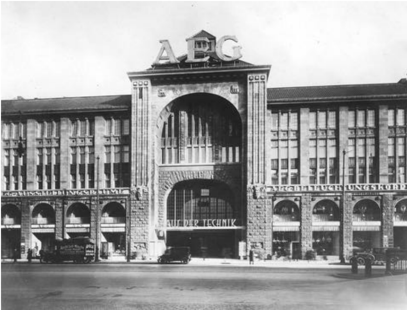
Abbildung 79: „Haus der Technik“; Torbau an der Friedrichstraße mit AEG Schriftzug, 1928
