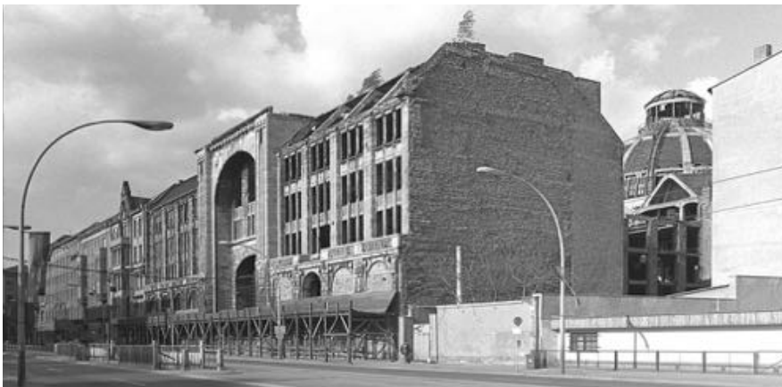
Abbildung 95: „Haus der Technik“; Fassade an der Friedrichstraße vor den Sprengungen, 1980
