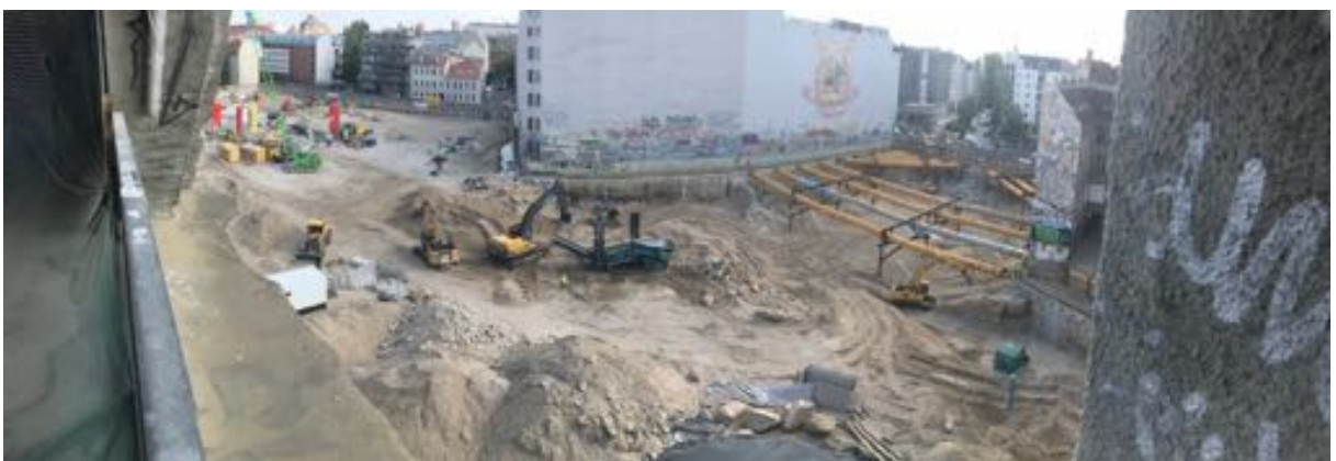
Abbildung 122: Das „Tacheles“; Blick aus dem „Tacheles“ auf das Areal, Beginn der Bauarbeiten, Stand Mai 2018 (v. I.H.)
