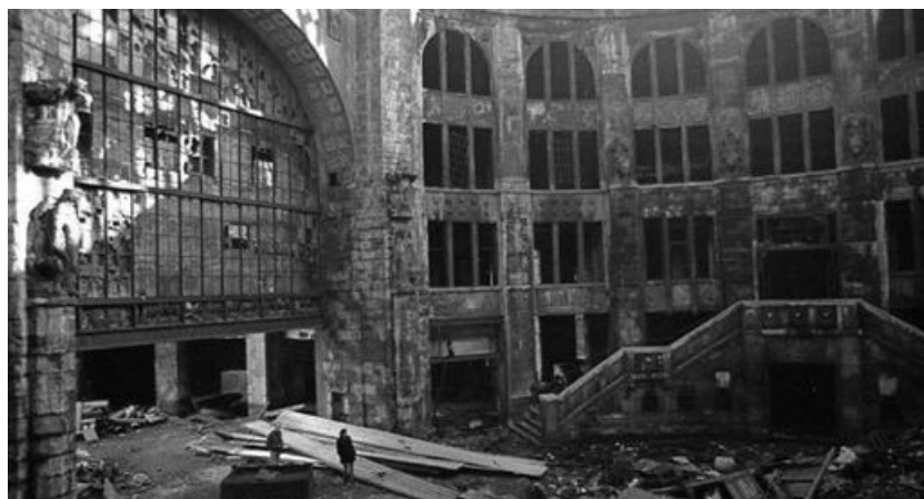
Abbildung 98: „Haus der Technik“; Blick in den ehemaligen Kuppelraum mit Freitreppe um 1980
