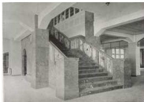
Abbildung 15: Innenliegende Marmortreppe im Zwischengeschoss, 1909
