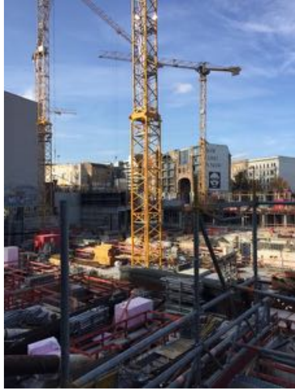
Abbildung 128: Bauarbeiten auf dem Areal „AM TACHELES“, Stand Oktober 2019 (v. I.H.)
