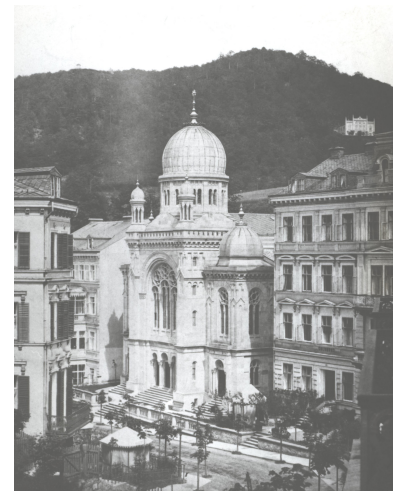
Abb. 12: Straßenseitige Fassade der Synagoge, Blick von Westen.
