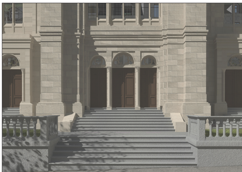
Abb. 48: Detail: Eingang von der Parkstraße aus gesehen.
