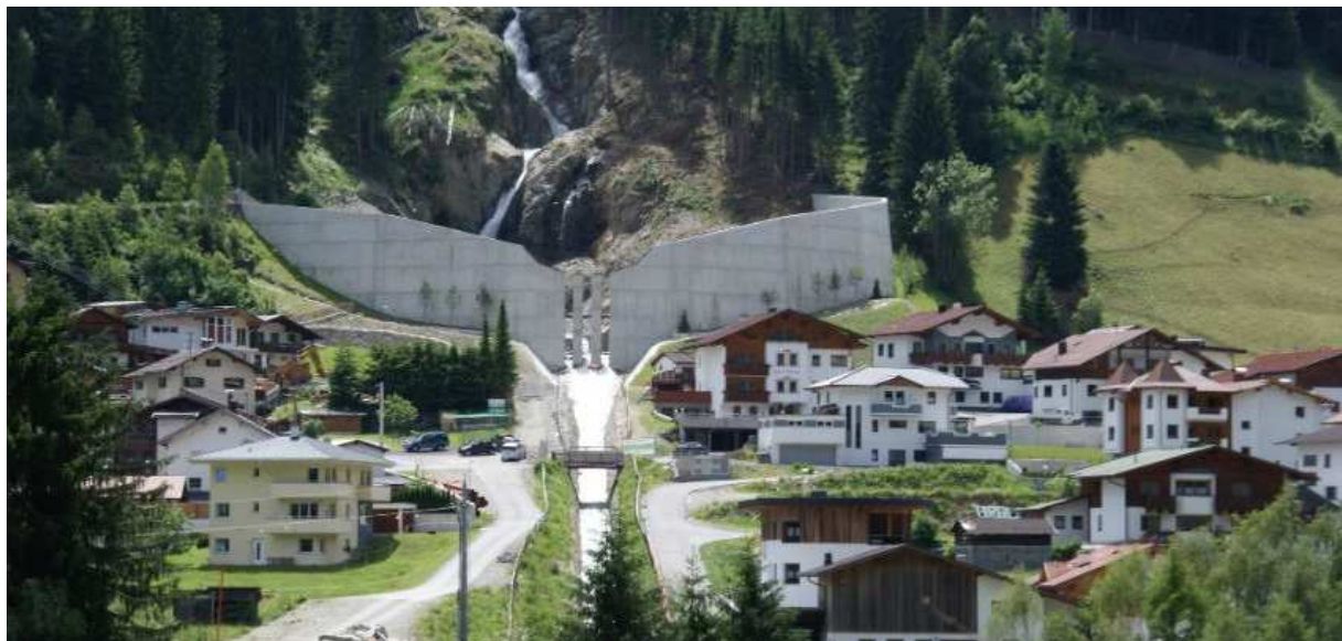
Abbildung 43: Geschiebesperre Schallerbach (KOLP 2017)
