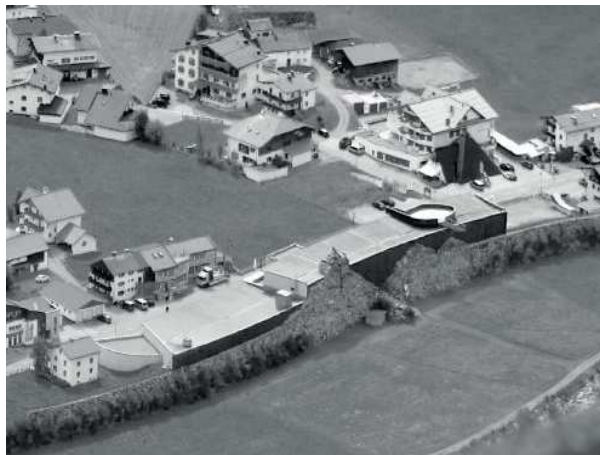
Abbildung 46: Lawinenschutzmauer Winkl (TITZ et al. 2016: 9)
