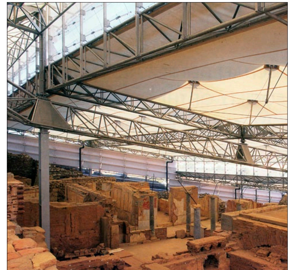
Abb.22: INNENANSICHT SCHUTZBAU (WOHNEINHEIT 5)
