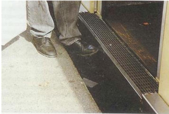
**Abb. (52):** Ein Fuß passt gut in einen 10 cm breiten Spalt
