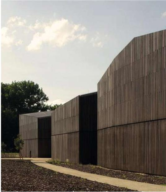
Abb.44 Holzlamellen an der Fassade
