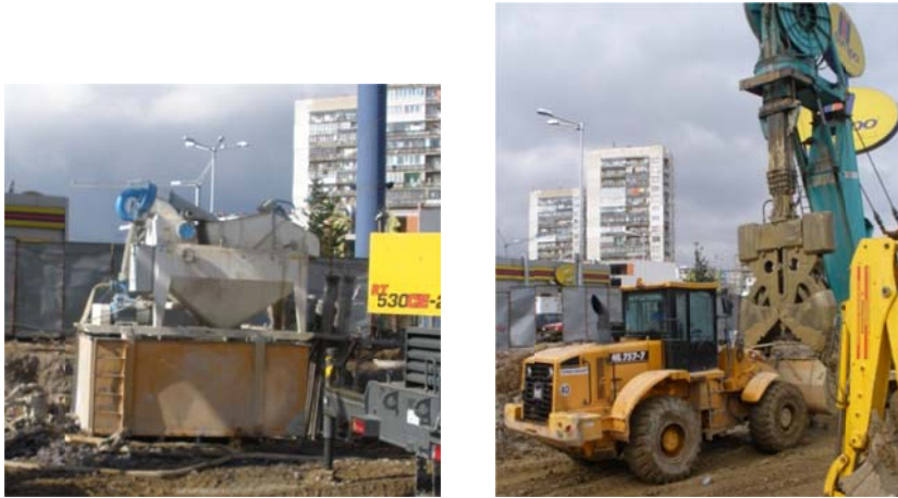
Abb. 46: Mischanlage (links) und Hydraulik-Seilbagger mit Greifer 78
