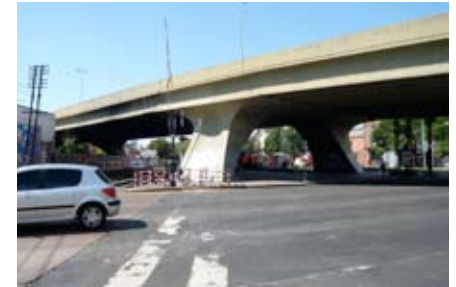
Abb. 64 Brücke Av. Juan B. Justo über Av. Cordoba und Bahn
