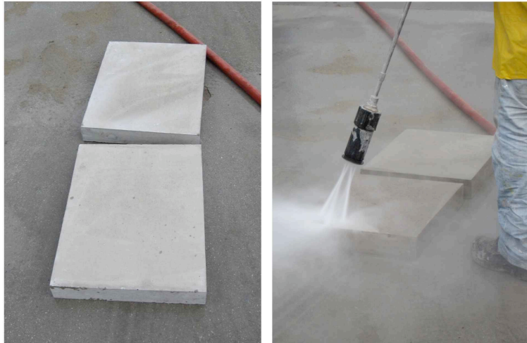
Abbildung 3.2: Wasserstrahlbehandlung der Betonoberfläche [Pey09]
