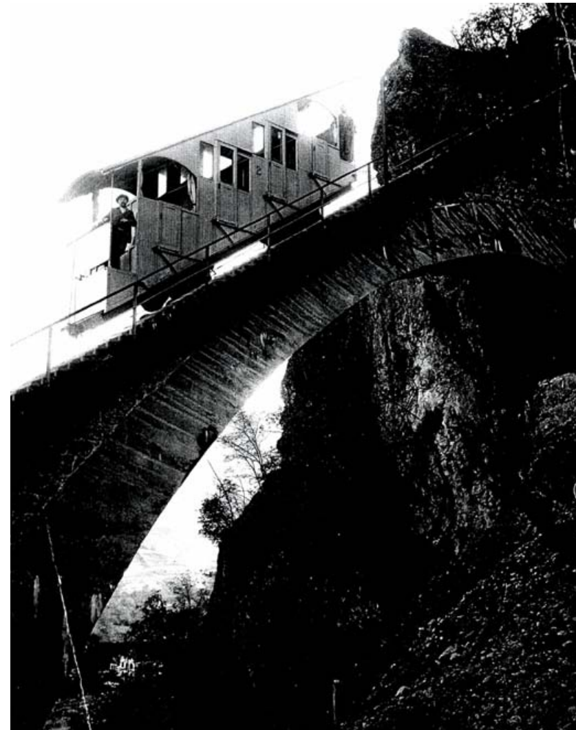
Abb. 28: Viadukt mit Standseilbahn, ca. 1918
