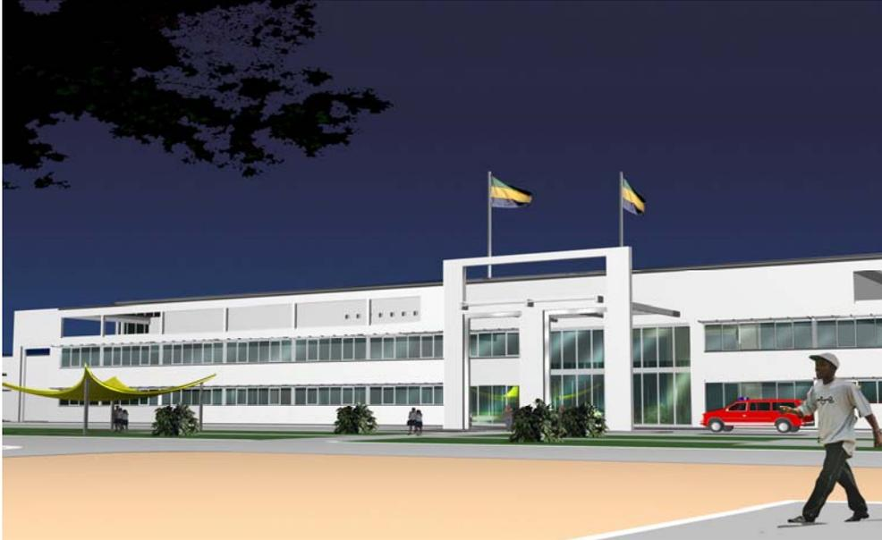
Bei diesem Entwurf handelt es sich um ein allgemeines Krankenhaus mit 160 Betten. Das Krankenhaus besteht aus drei Geschossen mit einer Gesamt M2 Zahl von 17.112 M2. Das Gebäude selbst ist aufgegliedert in einem dreigeschossigen Haupttrakt, zwei eingeschossige Nebentrakte und eingeschossige Nebengebäude (Trafo, Leichenhalle, Wachhütte, Verbrennungsanlage usw.).
