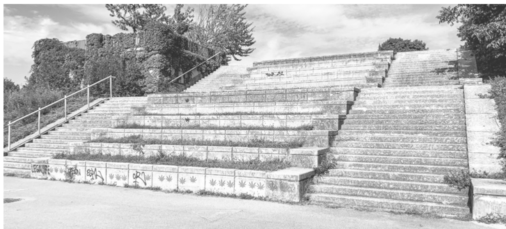
Abb. 75 Treppenanlage 1. Neue Donau
