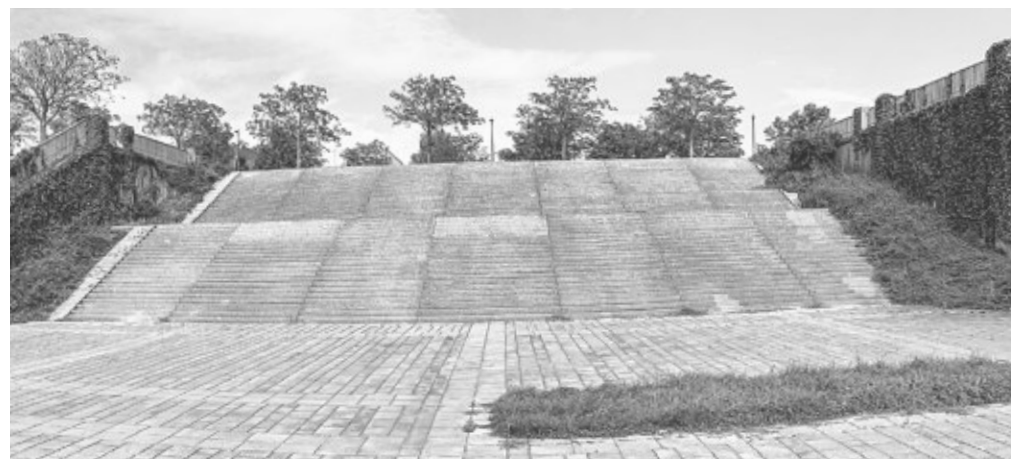
Abb. 76 Treppenanlage 2. Neue Donau
