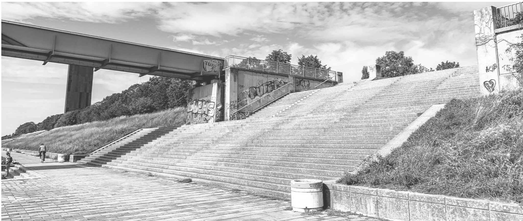
Abb. 77 Treppenanlage 3. Neue Donau
