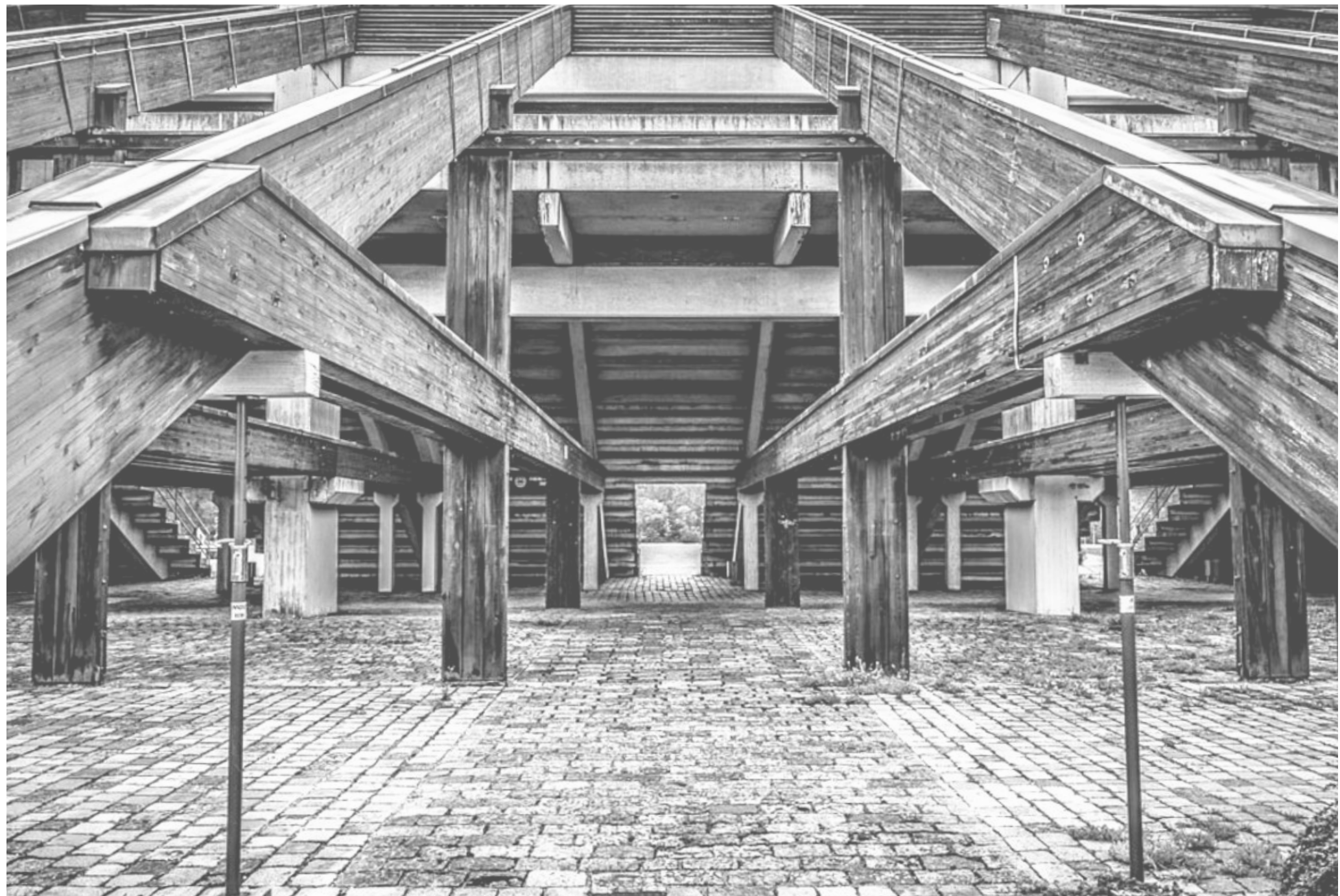
Abb. 9 Regattazentrum Oberschleißheim. München. Tribüne - Rückseite
