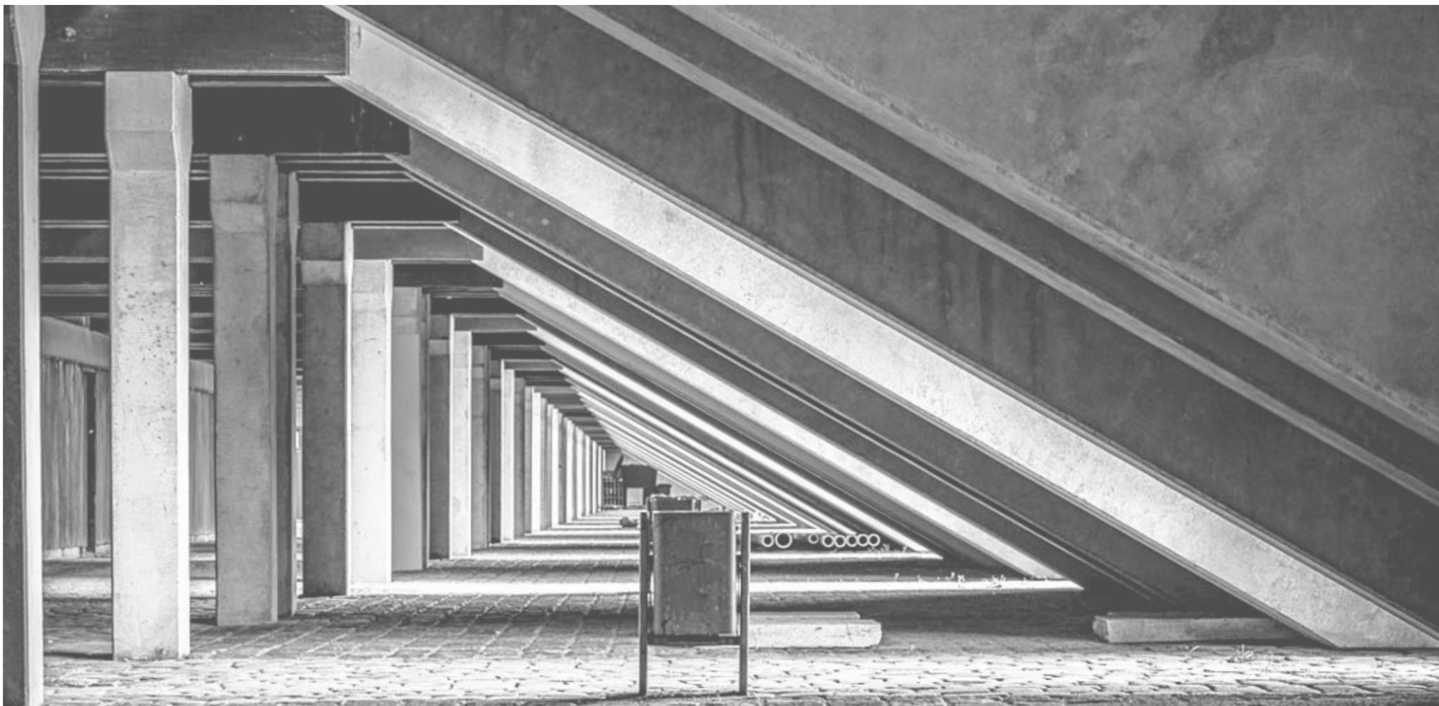
Abb. 10 Regattazentrum Oberschleißheim. München. Tribüne - Rückseite. Längsansicht
