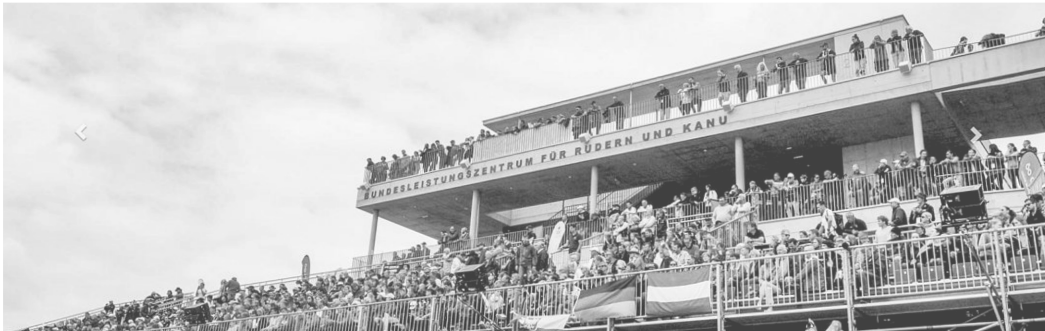
Abb. 18 Bundesleistungszentrum für Rudern und Kanu. Ottensheim. Linz. Tribüne. 2018
