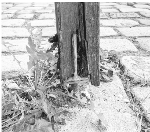
Abb. 28 Verfäulte Stützensehle
