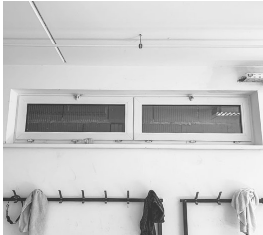
Abb. 40 Das zugemauerte Fenster. Garderobe Herren
