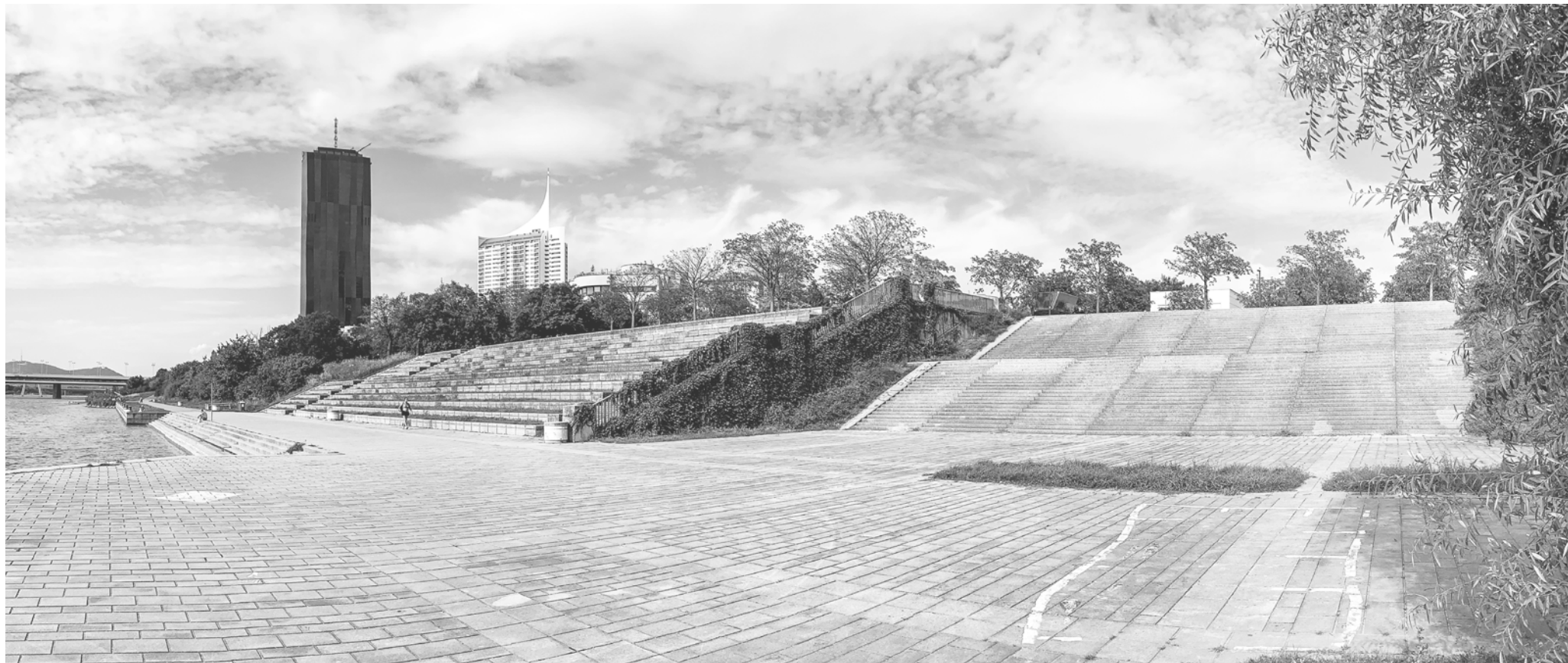
Abb. 74 Treppenanlagen. Neue Donau
