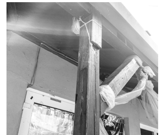
Abb. 32 Verfäulte Stütze.
