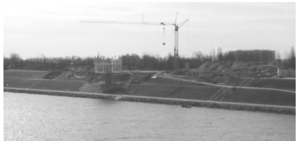
Abb. 5 Errichtung des Ruderzentrums
