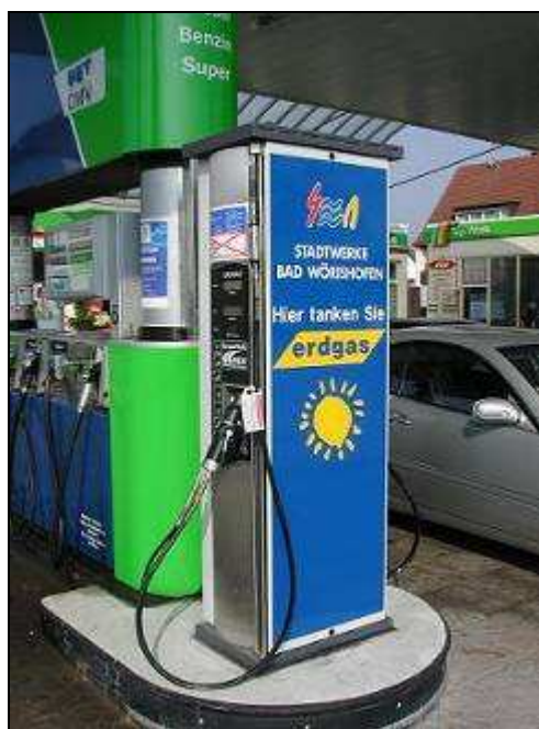
Abb. 4.10: CNG-Fast-Fill-Tankanlage an einer öffentlichen Tankstelle; Quelle: [Q 120]
