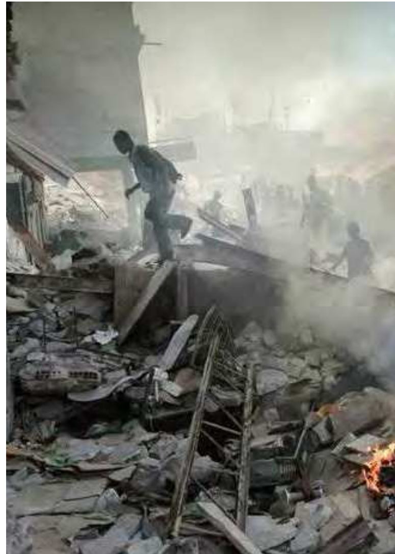
Abb.21. Eingestürzte Gebäude nach einem Erdbeben in Port-au-Prince.
