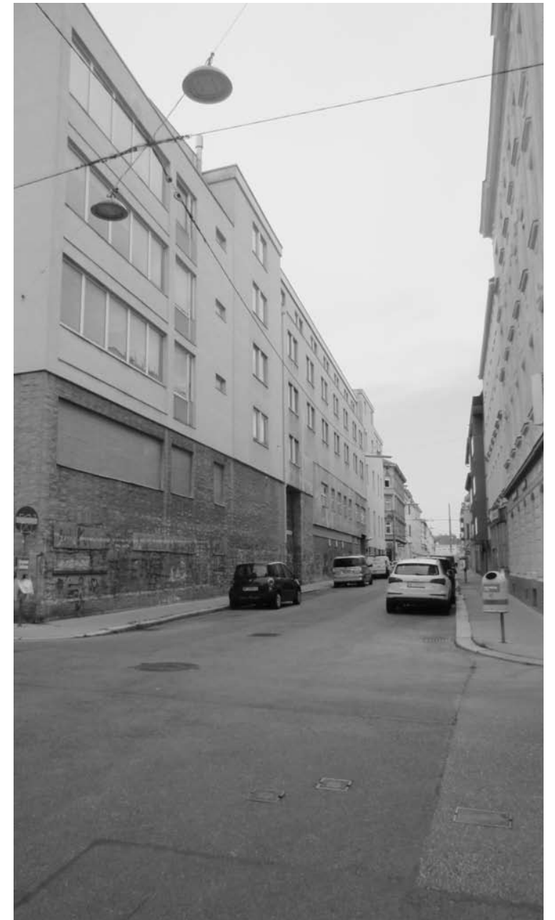
Bestandsbau im Frühjahr 2019 Situation der Seitengasse, Antonigasse
