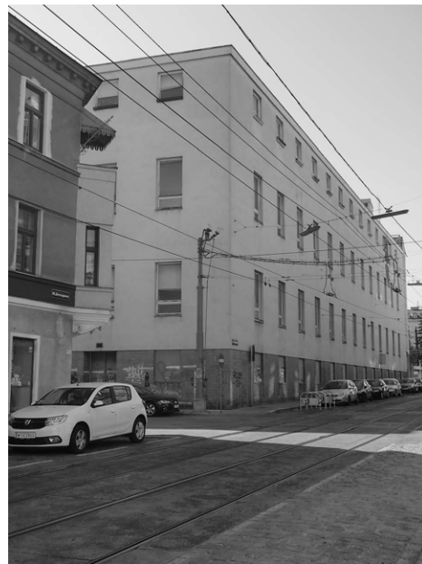
Bestandsbau im Frühjahr 2019 Situation an Seitenstraße, Mitter- berggasse Ecke Kreuzgasse
