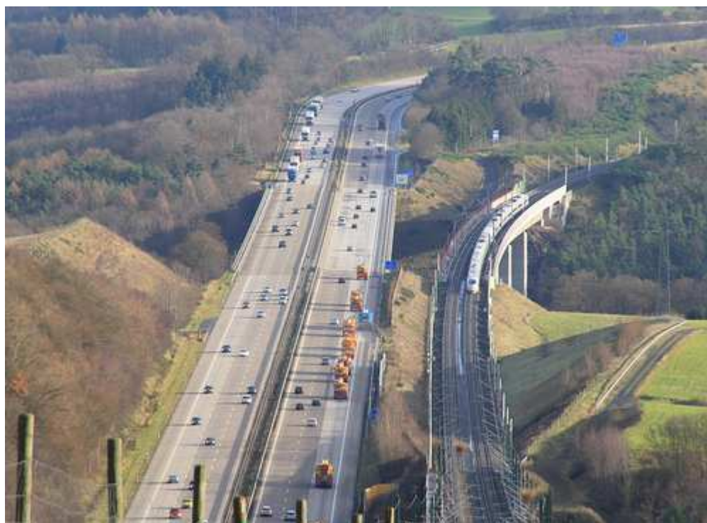
Abbildung 5: Vergleich der Flächeninanspruchnahme zwischen Autobahn und ICE Neubaustrecke
