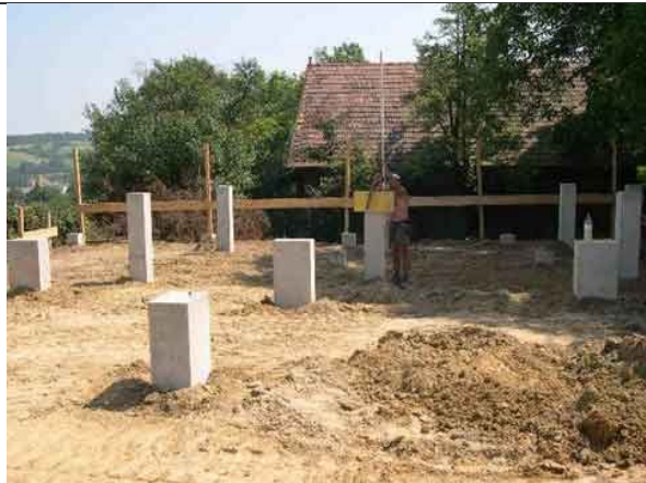
Materialverbrauch senken mittels Punktfundamenten
