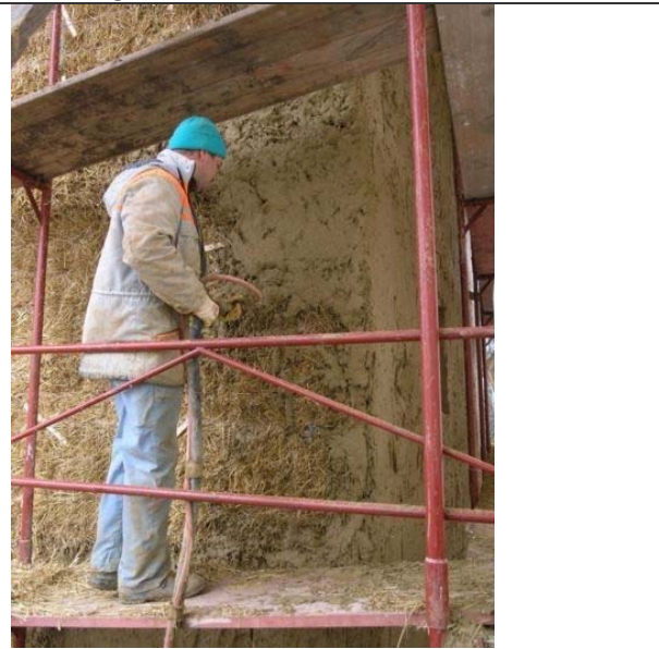
Maschinelles aufbringen des Lehmputzes
