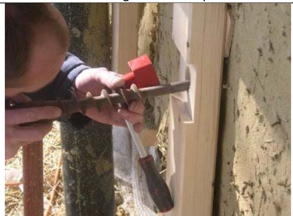
Befestigen der Konterlattung mittels bionischen Schrauben (Treeplast) aus biologisch abbaubaren Stoffen (Lignin, Holz).
