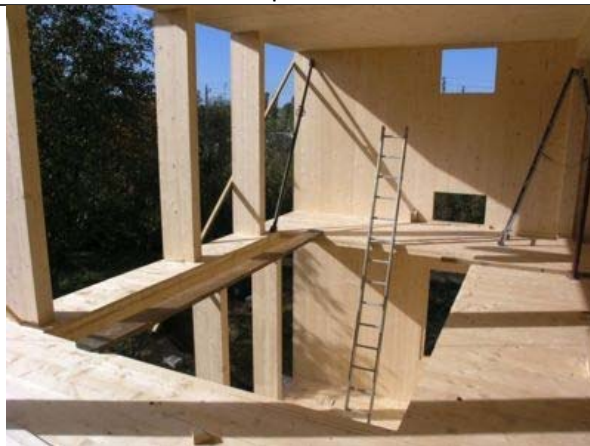
Freiraum für den späteren Einbau der Treppe
