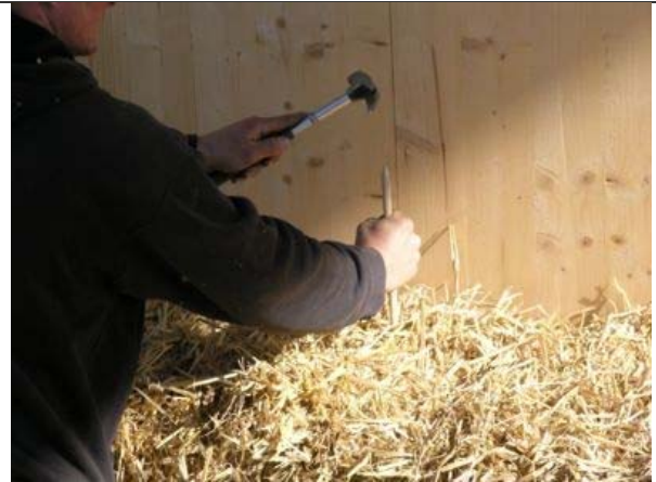
Fixierung der Ballen mit Holzdübel
