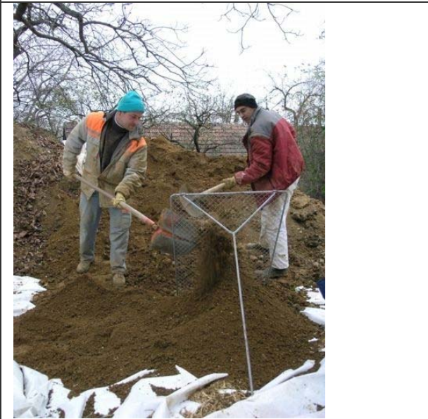
Aushub dient als Basis für den Lehmputz
