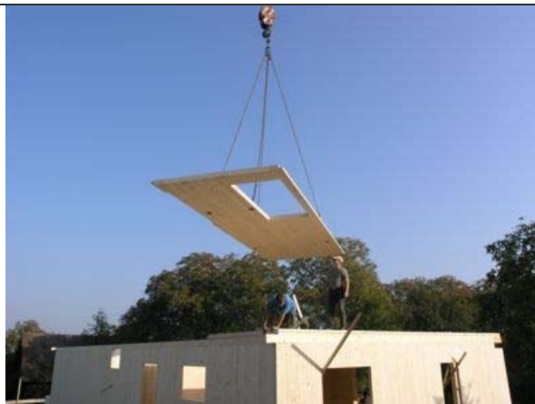
Montieren der Deckenplatten
