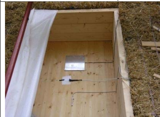
Anbringen von Sensoren zur Überwachung
