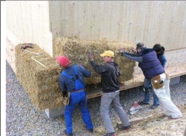
Versetzen der Strohballen
