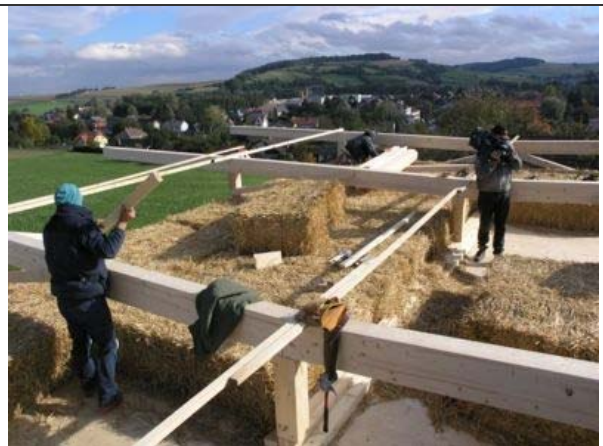
Dämmen der obersten Decke mit Stroh
