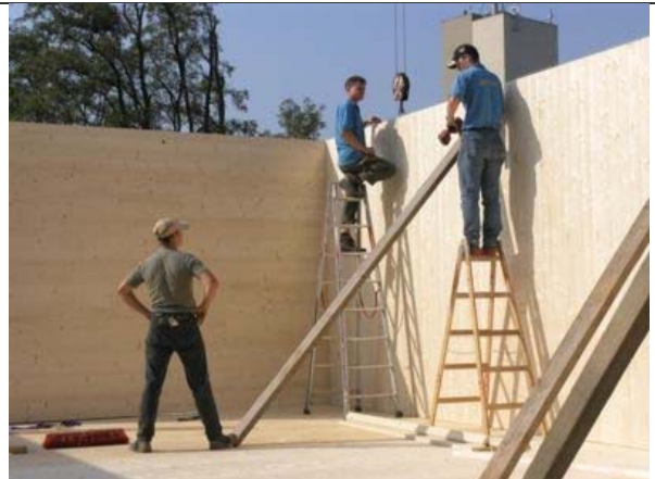
Aufstellen der tragenden Wandkonstruktion
