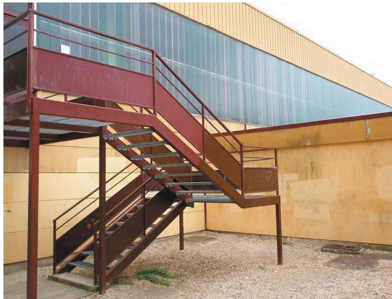
2.1.1.13. Die rostrote Feuertreppe der Schule in Lisses in Farbe
