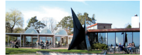
Abb.10 Museum Louisiana, Kopenhagen, Bo und Wohlert, begonnen 1956
