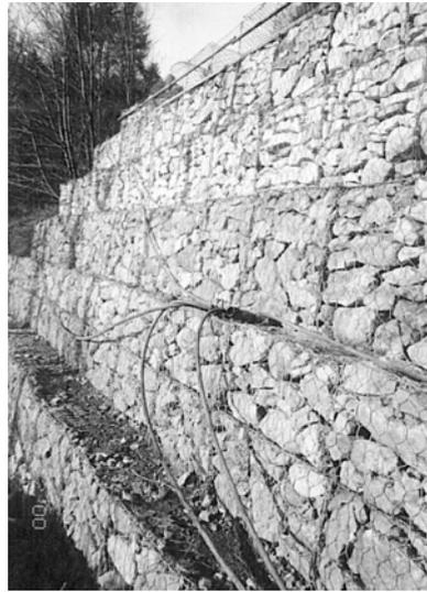
Bild 7.17: Stützmauer aus Gabionen, Brixlegg, Tirol [89]
