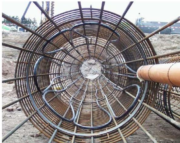
Bild 10.1: Bohrpfahl-Bewehrungskorb mit Absorberleitungen [28]
