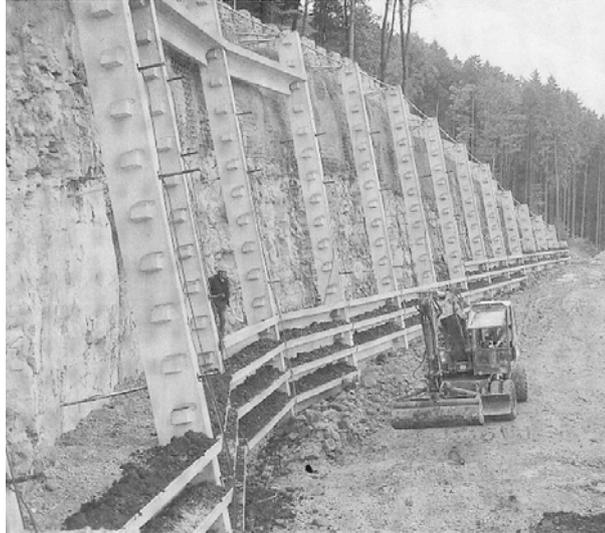
Bild 7.22: Beispiel eines Lisenen-Traversen-Systems [92]
