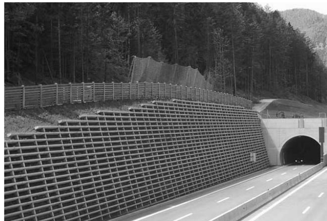
Bild 7.10: Raumgitterstützwand an der A9 Pyhrnautobahn, St. Pankraz, Oberösterreich [73]
