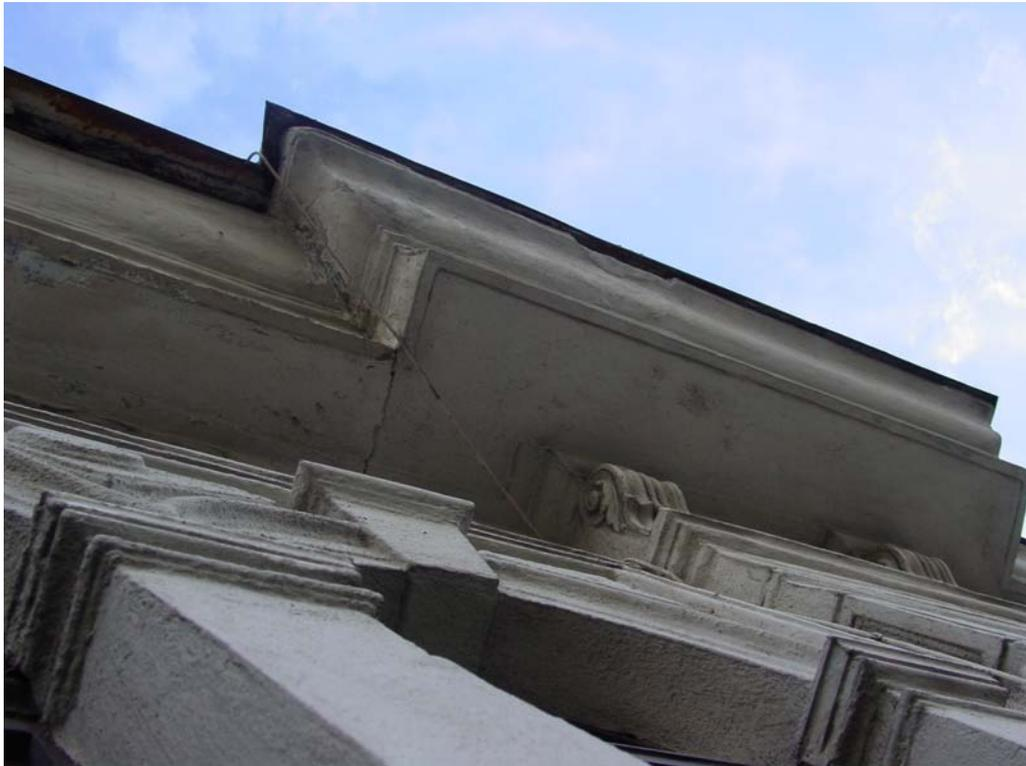
Abbildung C.1: Gesims am Amtshaus Währing, gut sind die Verwitterungsspuren zu erkennen
