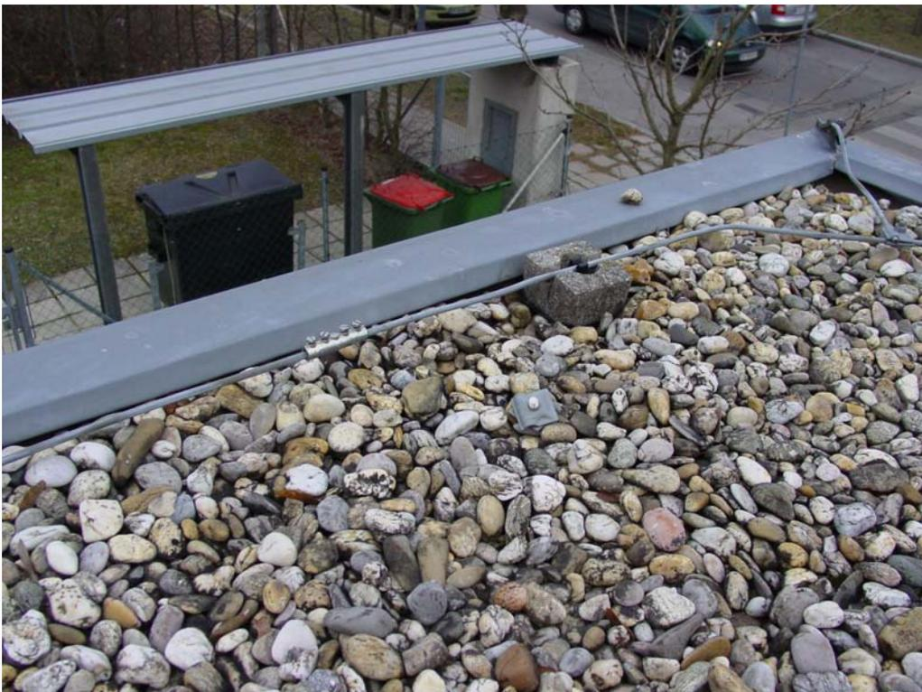
Abbildung F.2: Zu geringe Höhe der Attika, somit Gefahr der Überwehung der Beschüttung, Mindestüberstand sollte 2-mal den Größtkorndurchmesser der Beschüttung betragen; Korn ab Korngröße 16 ist zu verwenden
