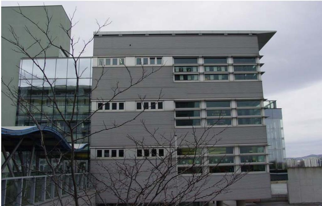
Abbildung E.1: Nordostansicht des Gebäudes, gut zu erkennen die außergewöhnliche Attikaform, Verschattungselement und den Freiraum unter dem Gebäude
