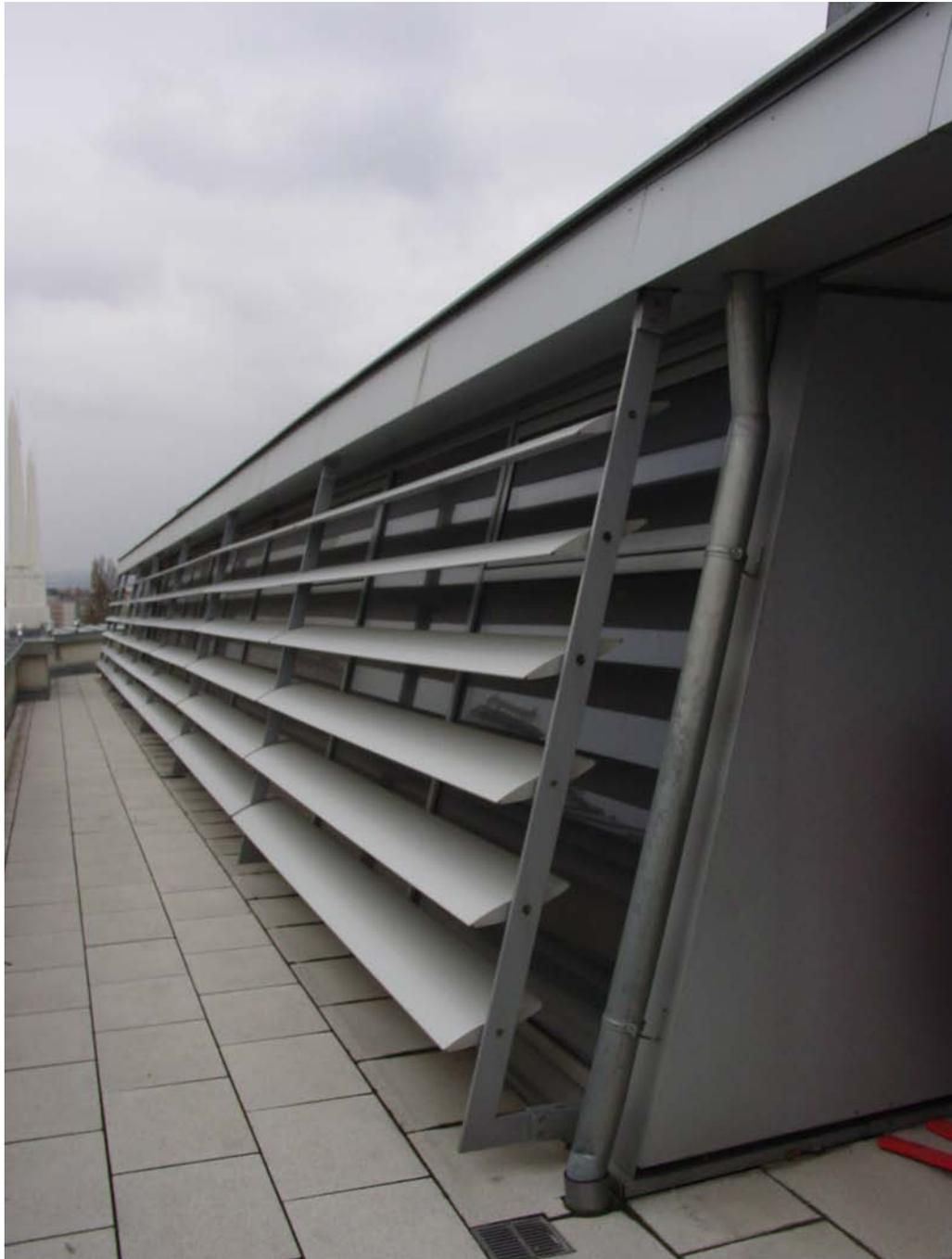
Abbildung B.2: Ersichtlich sind die aerodynamisch geformten Verschattungselemente am Dachbungalow
