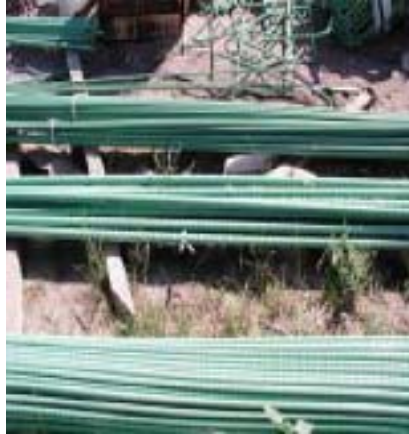
Abb.6: Epoxidharzbeschichtete Bewehrung [ www.ovbb.at ]
