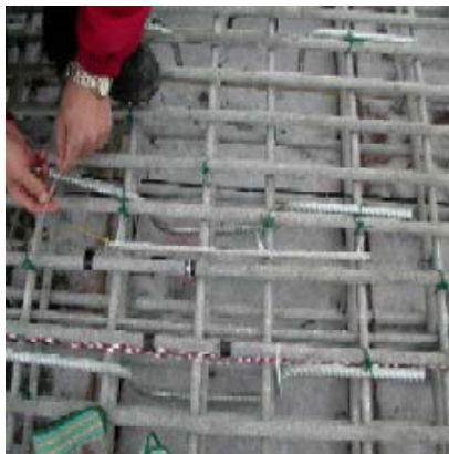
a) Bewehrung aus glasfaserverstärkten Kunststoffen
