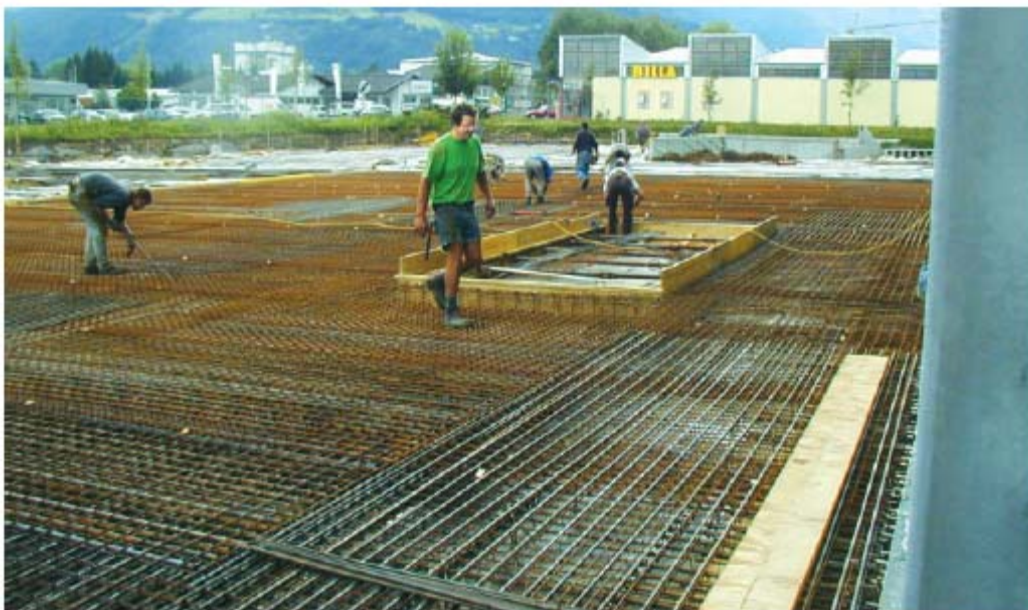
Abb. 17: Vorgespannte Decke in Österreich mit großem Anteil an Betonstahlbewehrung
