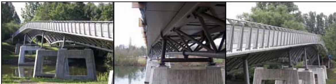
Abb. 14: Gärtnerplatzbrücke, Deutschland [www.gaertnerplatzbruecke.de]
