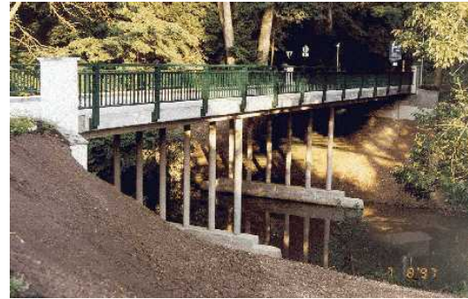
b) Badhausbrücke Tulln aus Hochleistungsbeton und ohne Abdichtung
