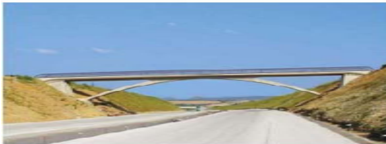
Abb.5: Bogenbrücke bei Wölkau aus Hochleistungsbeton ohne Abdichtung [www.ovbb.at]
