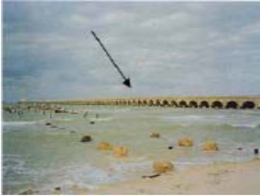
Brücke mit Edelstahlbewehrung (Bauzeit 1937-1941)
