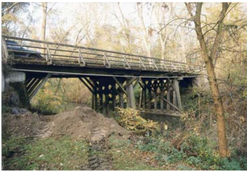
a) Ursprüngliche Badhausbrücke Tulln Stahl-Holz-Konstruktion
