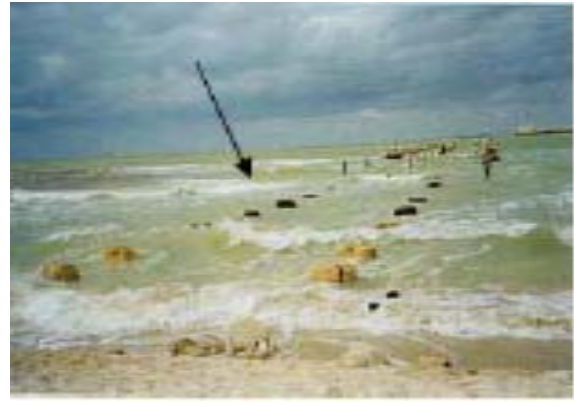
Pfeilerreste der Brücke von 1960
