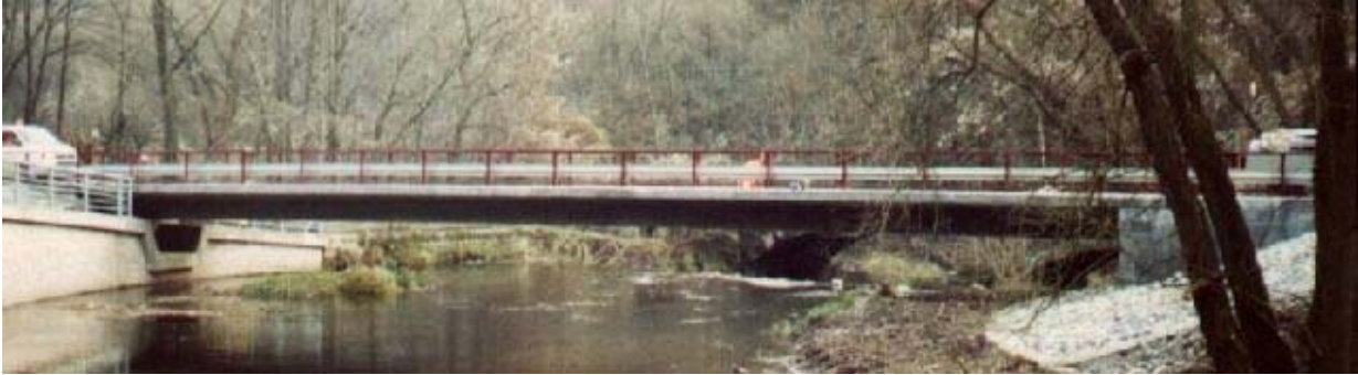
Abb. 4: Weißeritzbrücke aus Hochleistungsbeton ohne Abdichtung [www.lindlbauer.at/badhaus.html]
