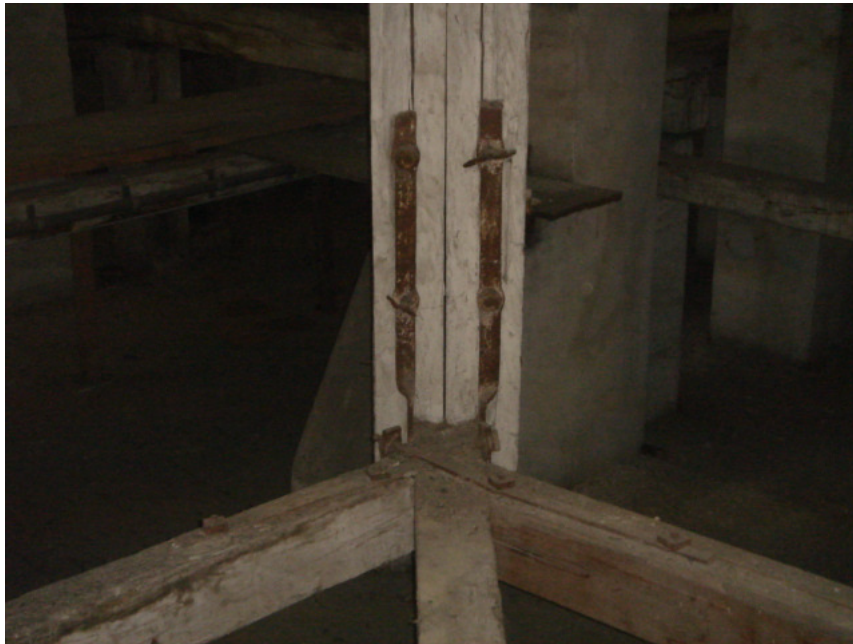
Abbildung 30: Bundtram und Hängesäule eines Diagonal-Haupgespärres. Knotenpunkt zweier Dachstühle
