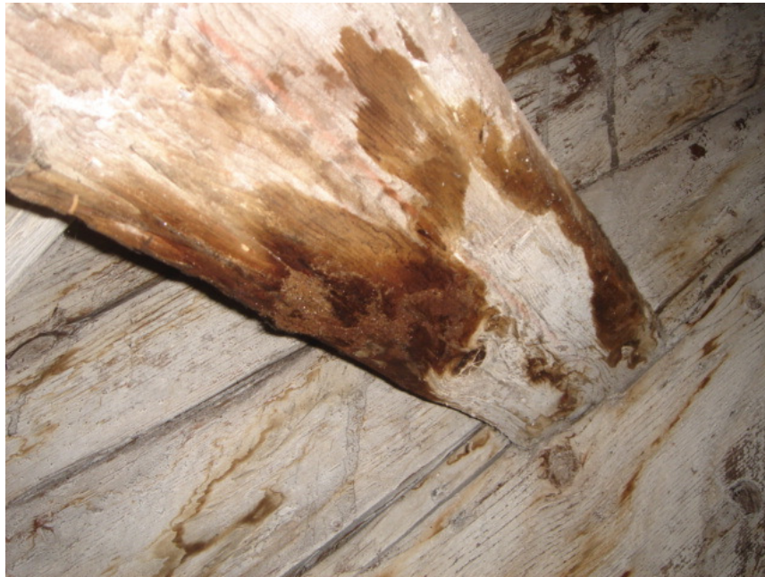
Abbildung 25: Verfärbung inkl. Kristallbildung an einem Brustriegel des Windverbandes
