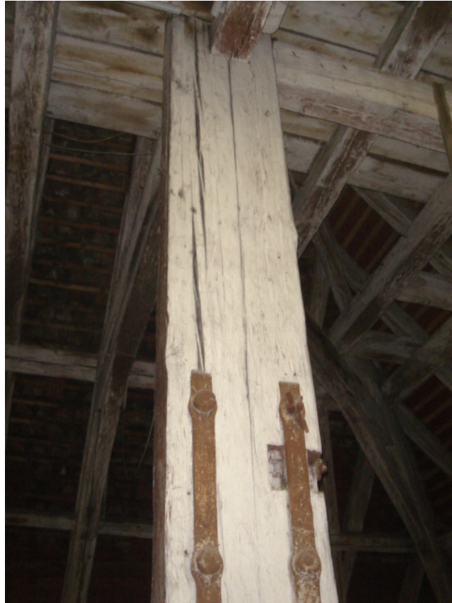
Abbildung 31: Schwindrisse im Querschnitt einer Hängesäule
