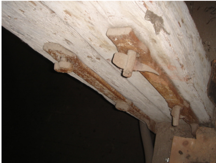
Abbildung 33: Hängeeisen - Oberflächenrost und Lockerung
