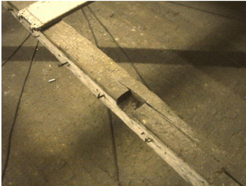
Abbildung 32: Querschnittsverringering an einem Bundtram (Auflager für Wartungssteg)
