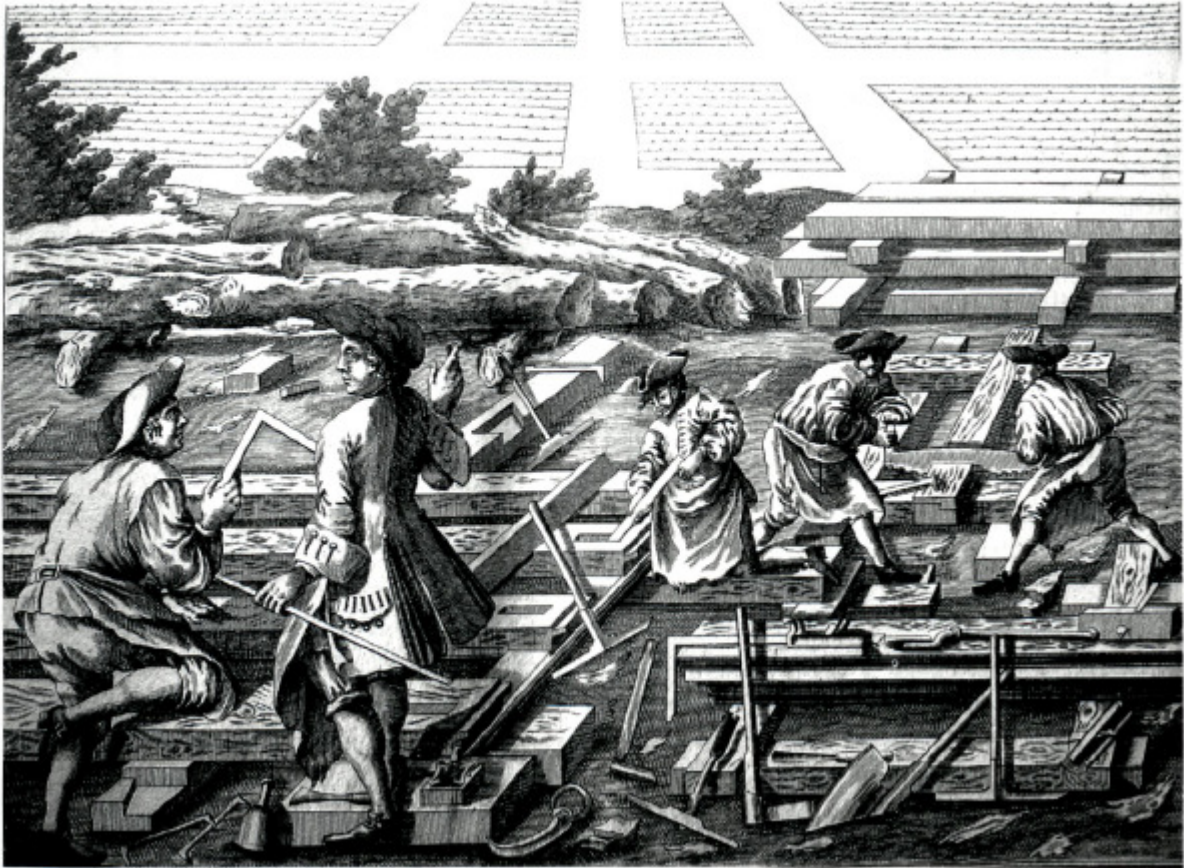
Abbildung 15: Der Zimmerplatz in der Barockzeit. Arbeiter beim Abbinden eines Dachstuhls (Quelle: Holzer 2008)
