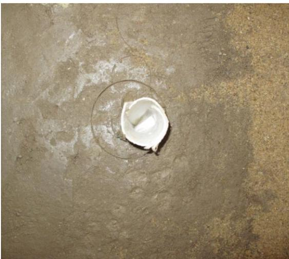
Abbildung 9.41: Bohrloch mit Geokunststoff
