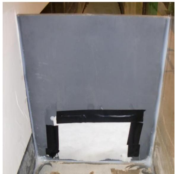
Abbildung 9.6: Auslass mit Geotextil (Innenansicht)
