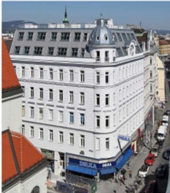
Abb 23: nach der Sanierung Quelle: Solidbau 2010
