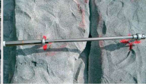
Abb. 5-10: Fissurometer mit Wegaufnehmer (aus: Geodata, 2011)
